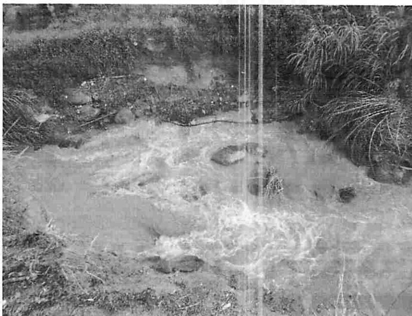
Foto 56. Leito do córrego que já sofre com erosão.
