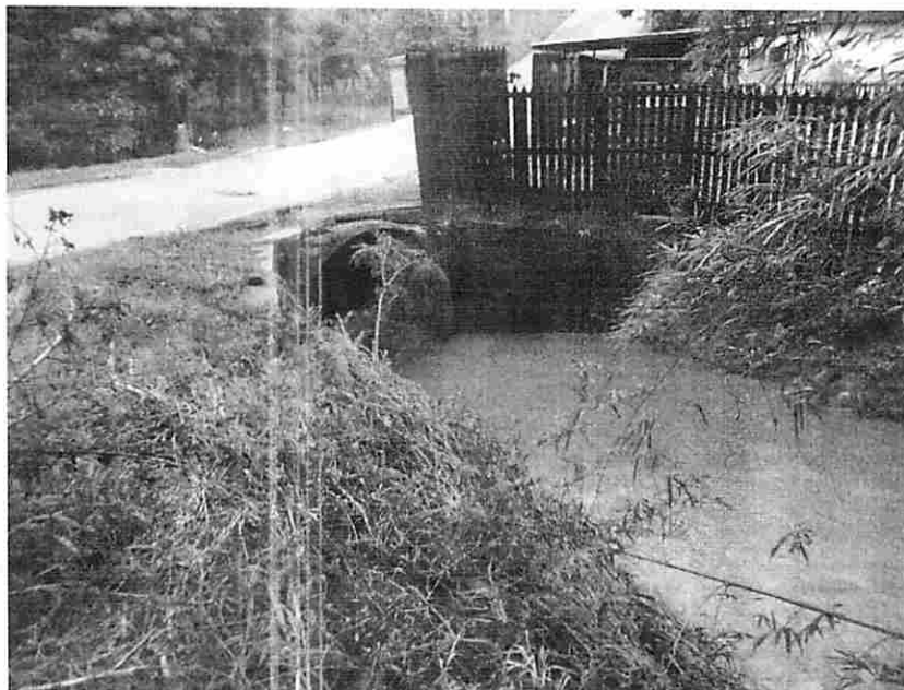
Foto 36. Aduela aparentemente não está entupida, localizada na Rua São Francisco próximo a Rua Durval Villaça
