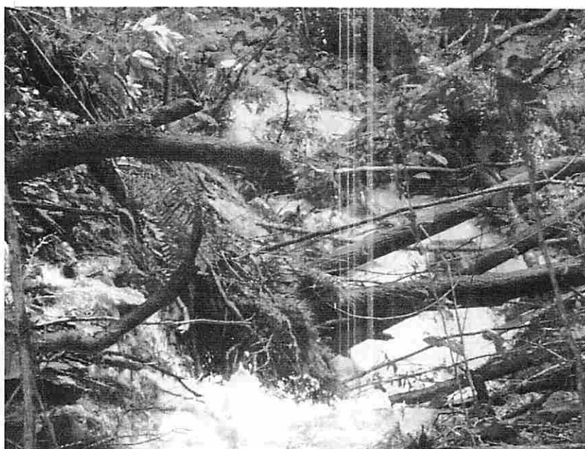
Foto 25. Nota-se vegetação arrastada pela força da água.
