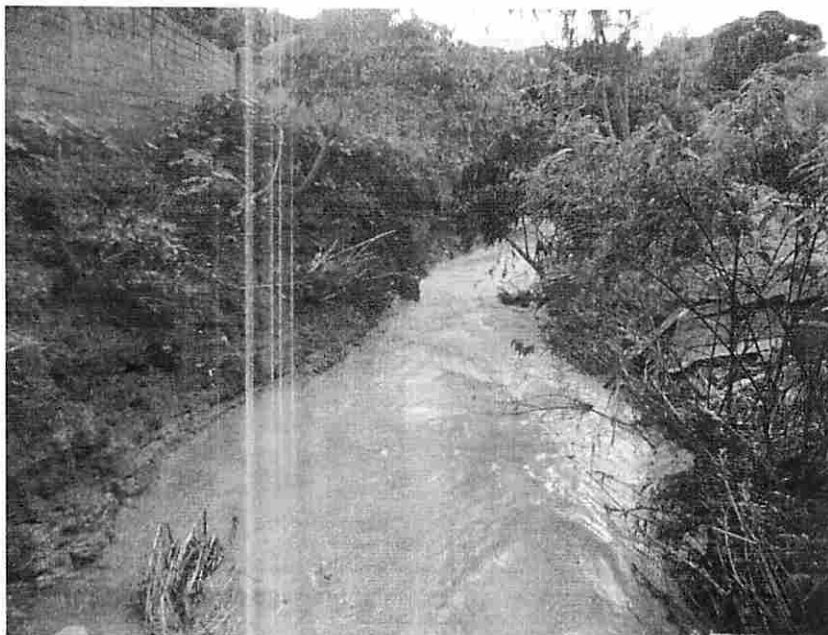
Foto 43. Córrego que vai para a ponte denificada.
