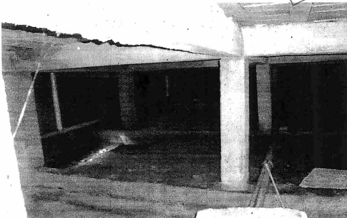
Foto 11) Vista que fica em baixo do prédio Residencial Ventura.
