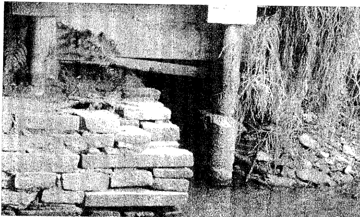
Foto 5) Lado Bairro do Carmo primeiro pilar de sustentação não apresenta instabilidade ou fissuras apenas o rio está abaixo do nível..
