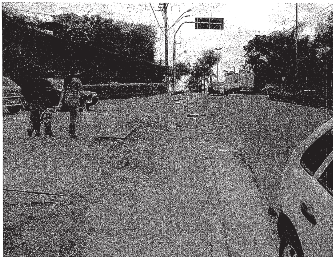
Trecho da Av. Varanguera
