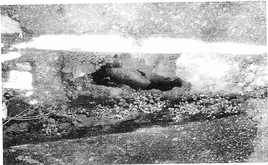
Foto 04) No início da escada há vazamento de esgoto.
