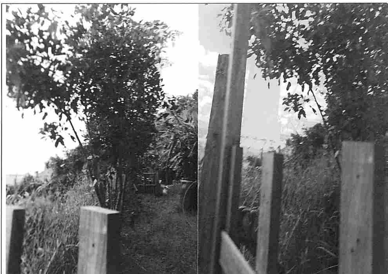
Foto n.º 18 – Km 05 – Invasão da área de domínio com edificações
