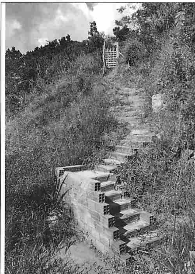
Foto n.º 16 – Km 05 - Invasão de faixa de domínio com edificações
