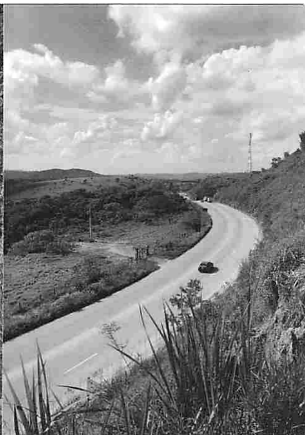
Foto n.º 17 – Km 05 – Vista da área invadida
