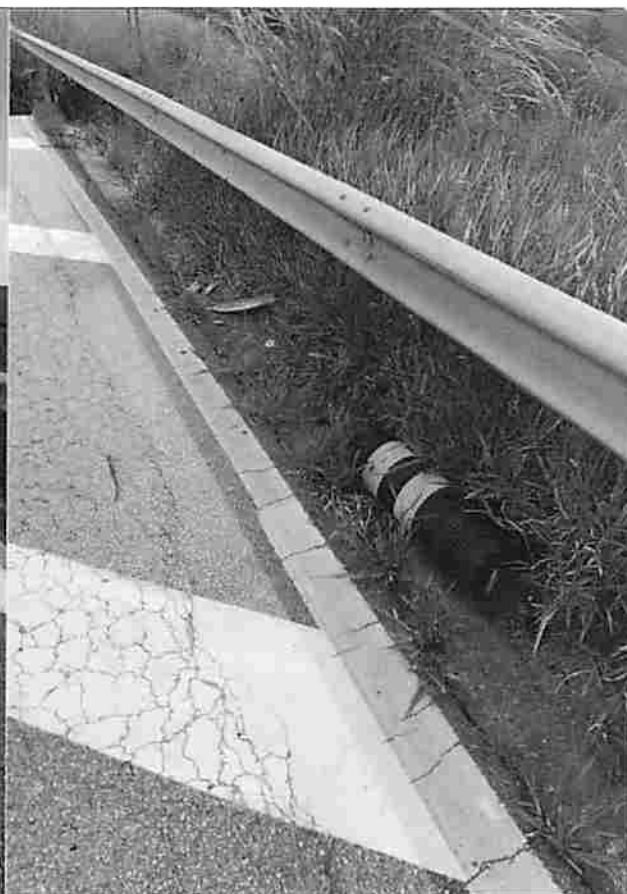
Foto n.º 06 – Balizadores já danificado
