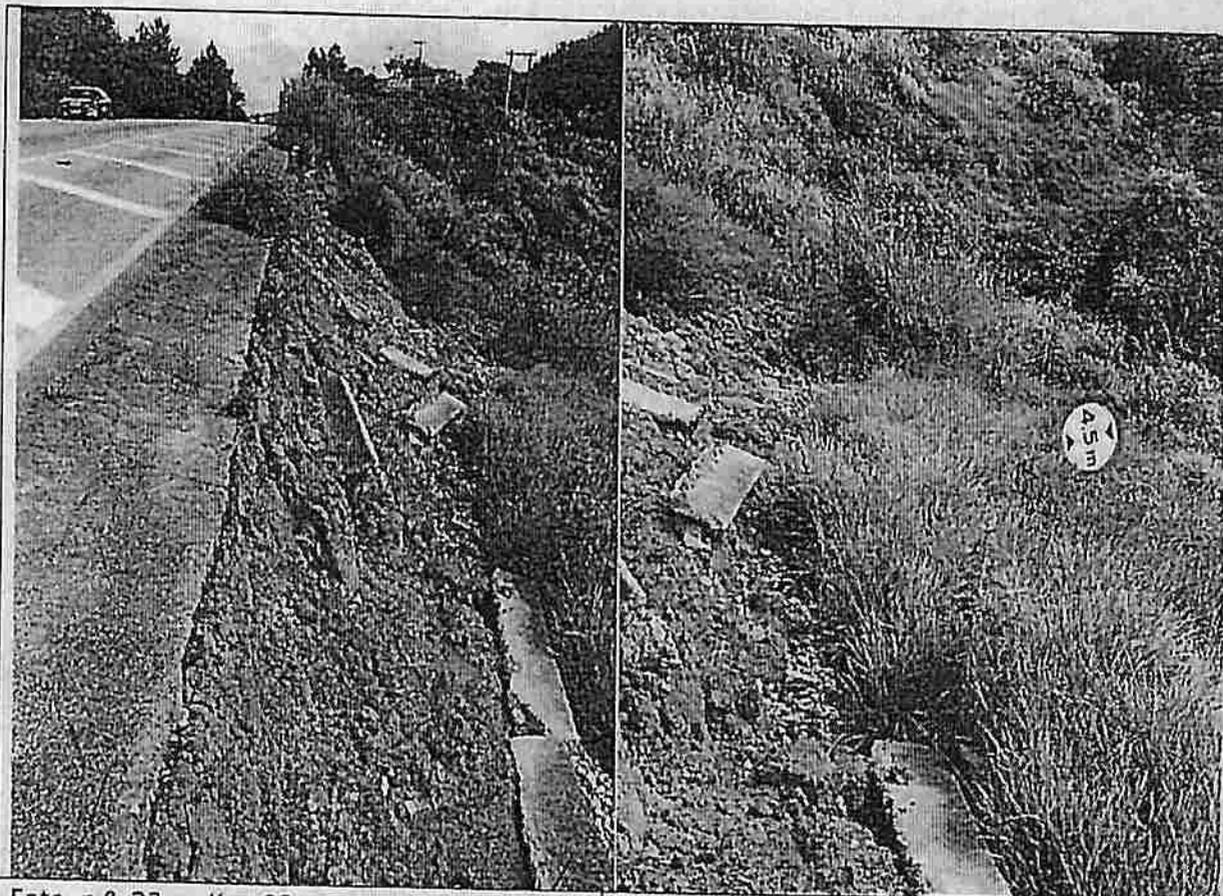
Foto n.º 23 - Km 08 - erosão do talude e rompimento da canaleta de concreto
