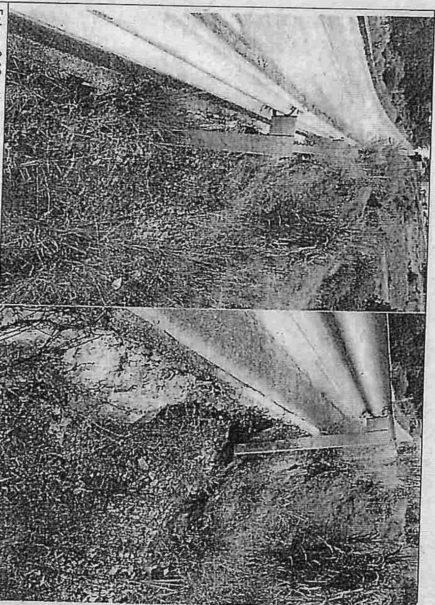
Foto n.º 19 – Km 7,5 – agravamento da erosão do talude
