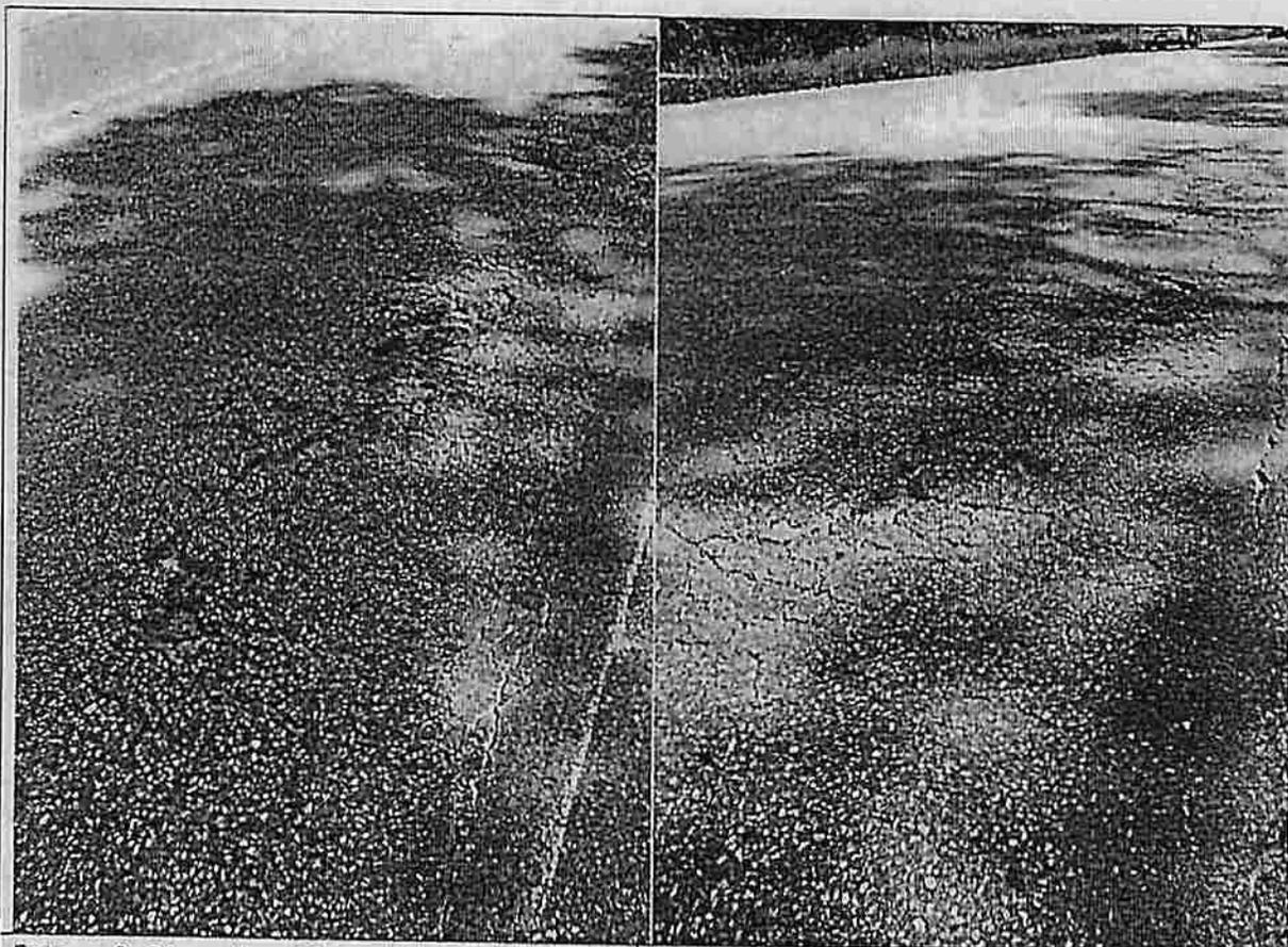
Foto n.º 01 - Km 02 - Trincas, fissuras e buracos na pista de rolamento da Rodovia
