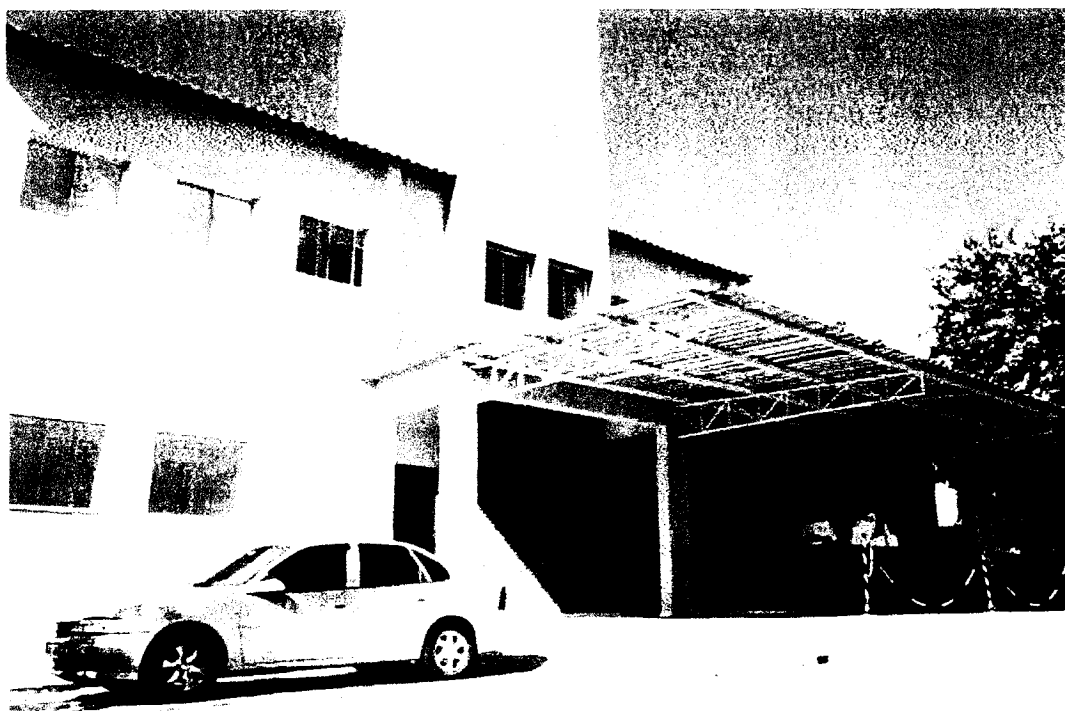
Figura 2: Fachada externa do prédio com vaga específica para ambulância e rampa de acesso para cadeirantes
