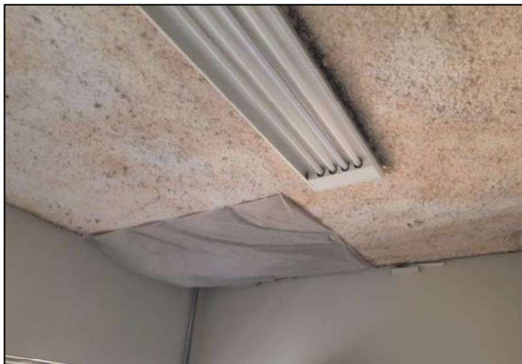
Imagem 5- Forro do “plenarinho” danificado devido ao acúmulo de água
