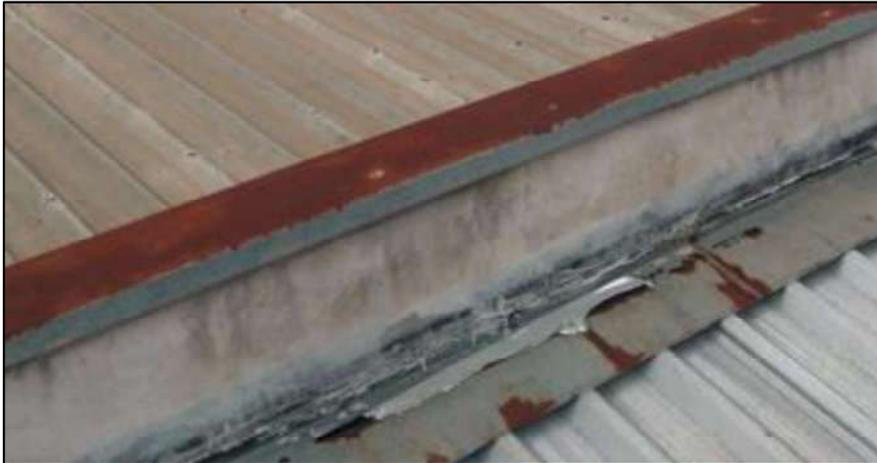
Imagem 11 – Rufos em condições inadequadas de utilização
