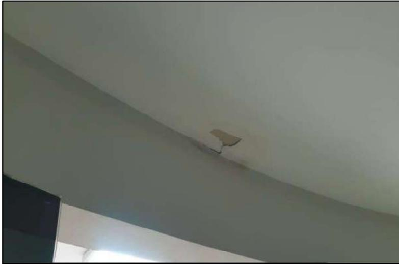
Imagem 3- Forro do Plenário lado externo com sinais de dano por infiltração
