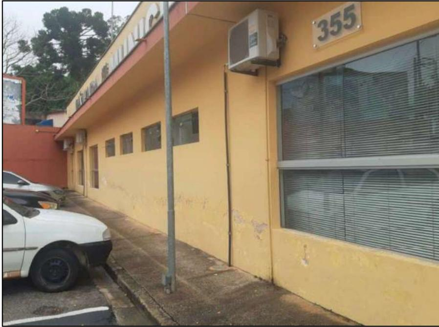
Imagem 9 – Fachada de frete ao estacionamento externo com pintura danificada devido à umidade existente.
