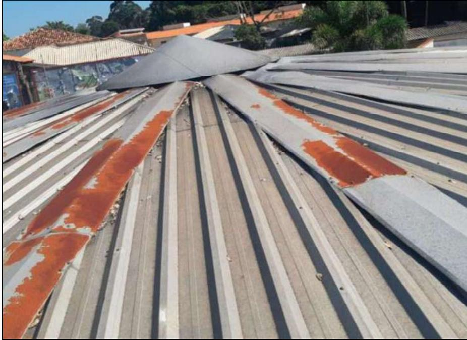
Imagem 13 – Cumeeiras em condições inadequadas para utilização
