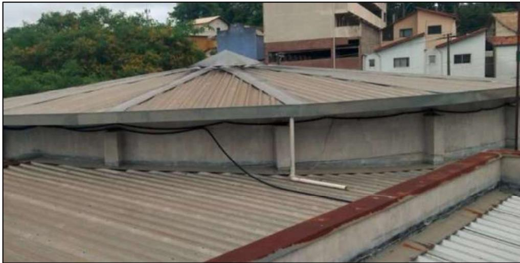
Imagem 15 – Coletor da calha inadequado com desague de água pontual sobre telhado
