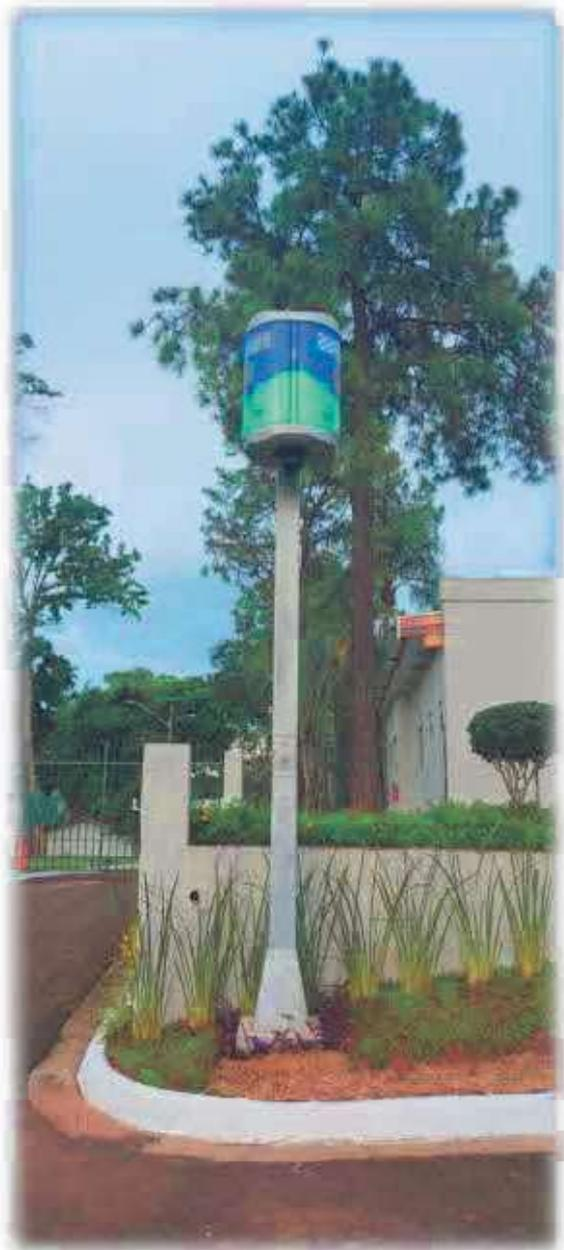
1. Sistema de repressão, monitoramento e atendimento a emergências caracterizado por compreender um equipamento dotado de um corpo de 74,2 x 58,0 x 58,0 instalado ao poste metálico de 4,5 metros;
