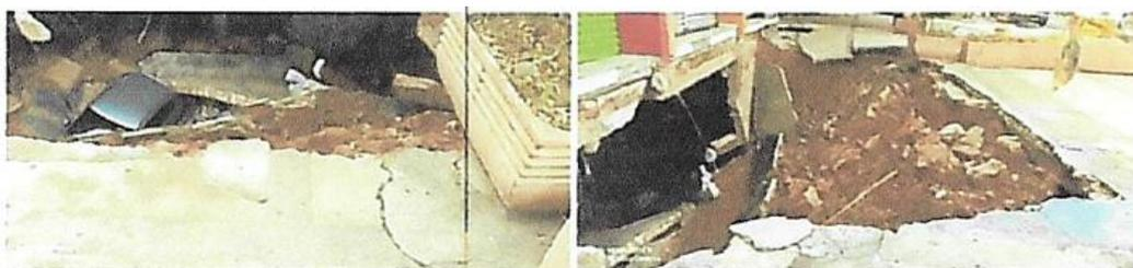
Fotos 06 e 07: vista da ruptura do pavimento de concreto simples do estacionamento, região assinalada na foto 05.
