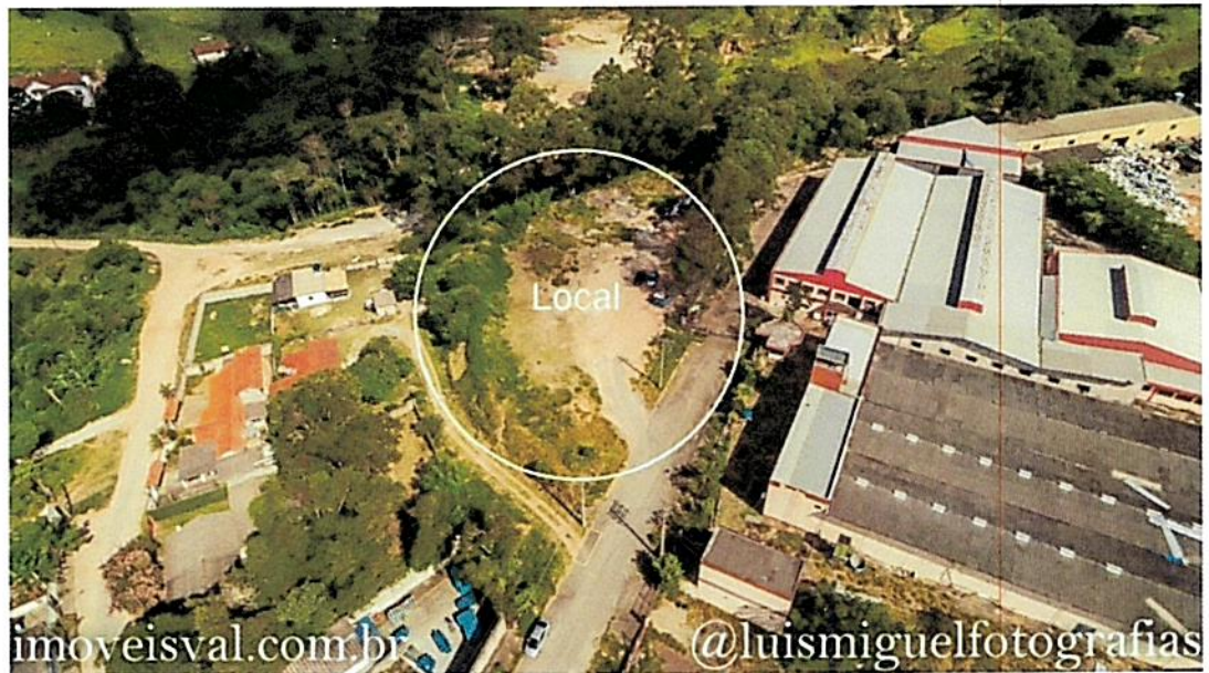
Foto 02 - Foto área do local do imóvel avaliando
