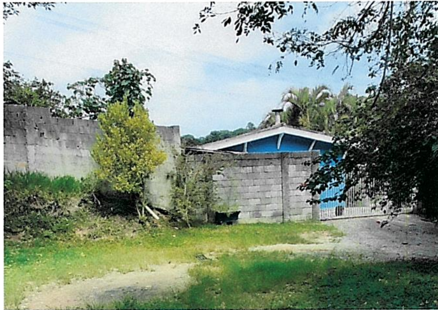
Foto 06 - Vista interna lado esquerdo
