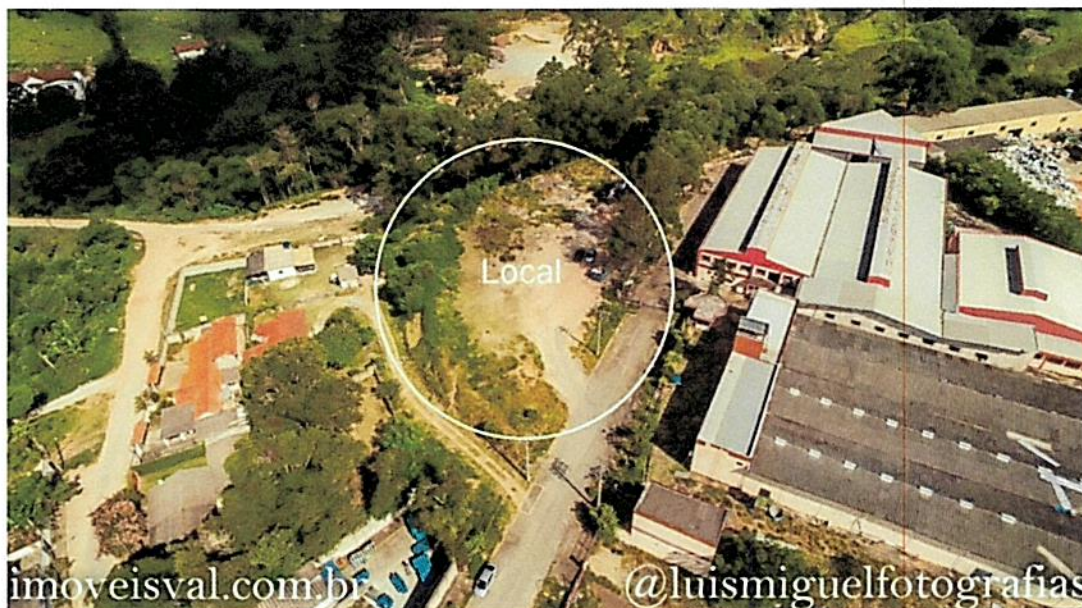
Foto 01 - Foto área do local do imóvel avaliando
