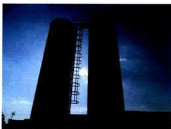
Foto 204- Reservatórios Goianã 1, 2 e 3
