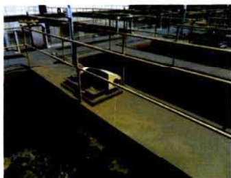
Foto 211- ETA São Roque
