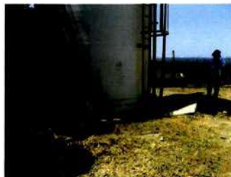
Foto 166-Reservatório Planalto Verde
