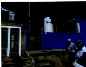
Foto 158-Reservatório Jd Marieta
