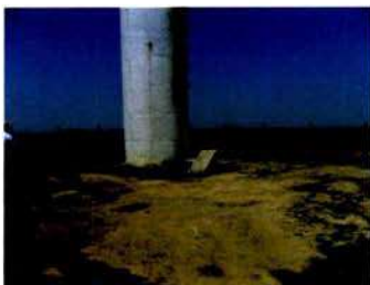
Foto 165- Reservatório Planalto Verde
