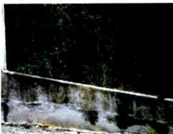
Foto 159- Reservatório Jd Marieta
