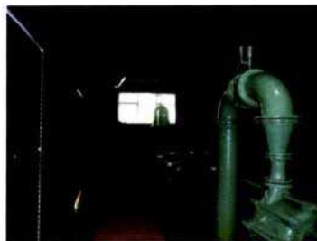
Foto 144- EEAT na Sede
