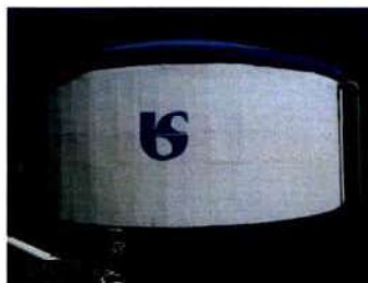
Foto 200- Reservatório Vila Nova São Roque
