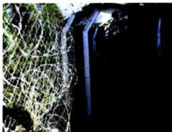
Foto 190-Reservatório do Carmo
