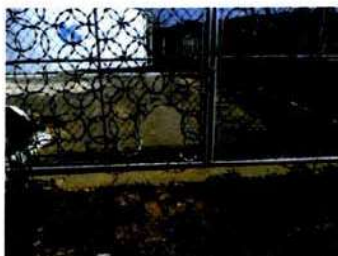
Foto 198- Reservatório Vila Nova São Roque
