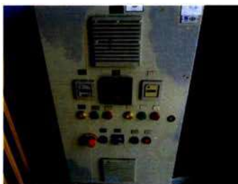
Foto 135- EEAT Vila Nova São Roque
