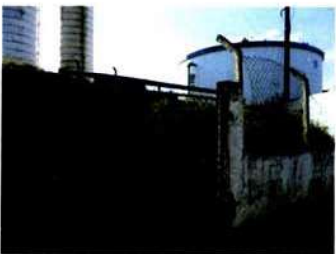
Foto 203- Reservatórios Goianã 1, 2 e 3
