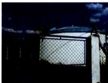
Foto 183- Reservatório São João Novo
