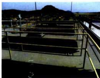
Foto 212- ETA São Roque
