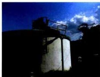
Foto 184- Reservatório São João Novo
