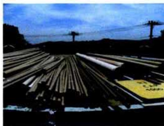
Foto 194-Reservatório da sede
