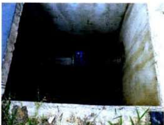
Foto 201-Reservatório Vila Nova São Roque
