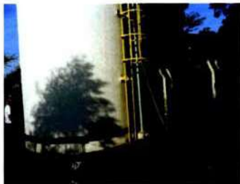
Foto 188- Reservatório do Carmo
