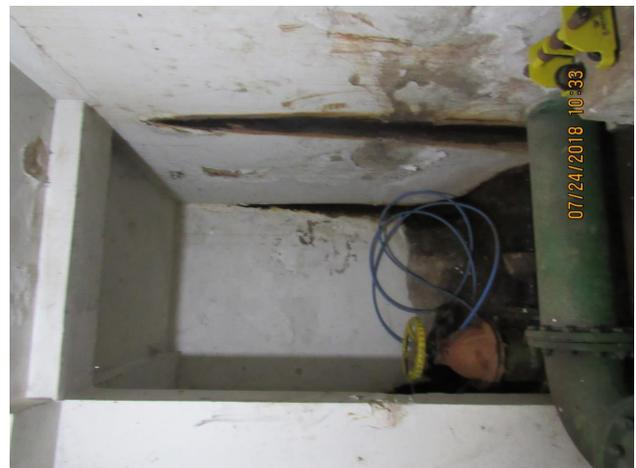
Constatação **62-2020-CT-2**: Incidência de esgotos no manancial devido à precariedade do sistema de esgotamento sanitário.
