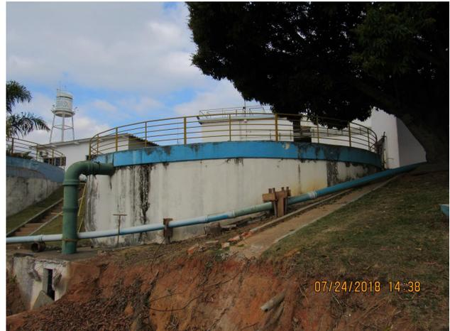
Constatação **62-2020-CT-9**: Refere-se à falta de pintura, degradação das estruturas civis e corrosão da armação do concreto, dentre outros.
