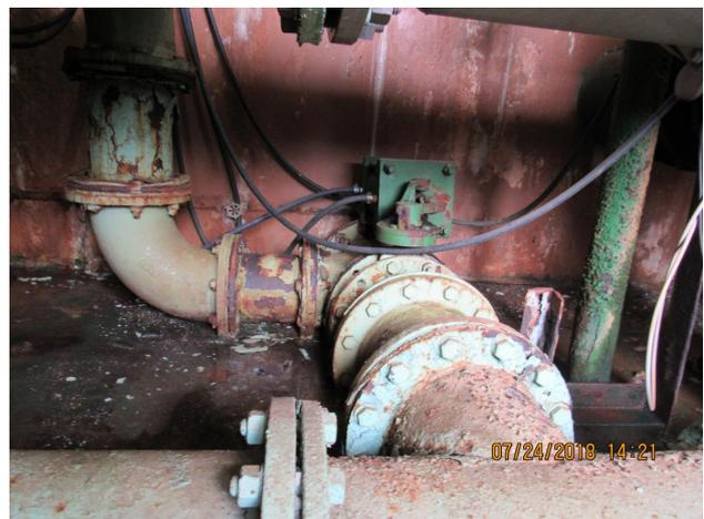
Constatação **62-2020-CT-7**: Corrosão de tubulações, válvulas e outros.
