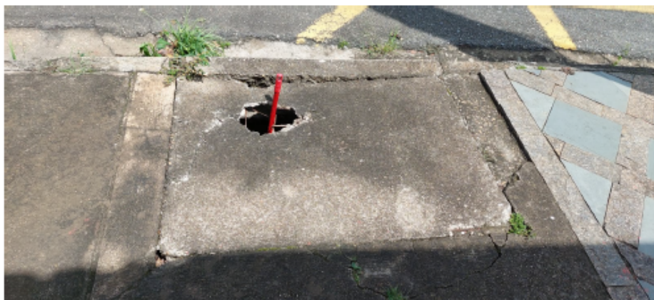
Figura 1 - Esquina da Rua dos Lírios com a Rua São José - Bairro Santo Antônio.
