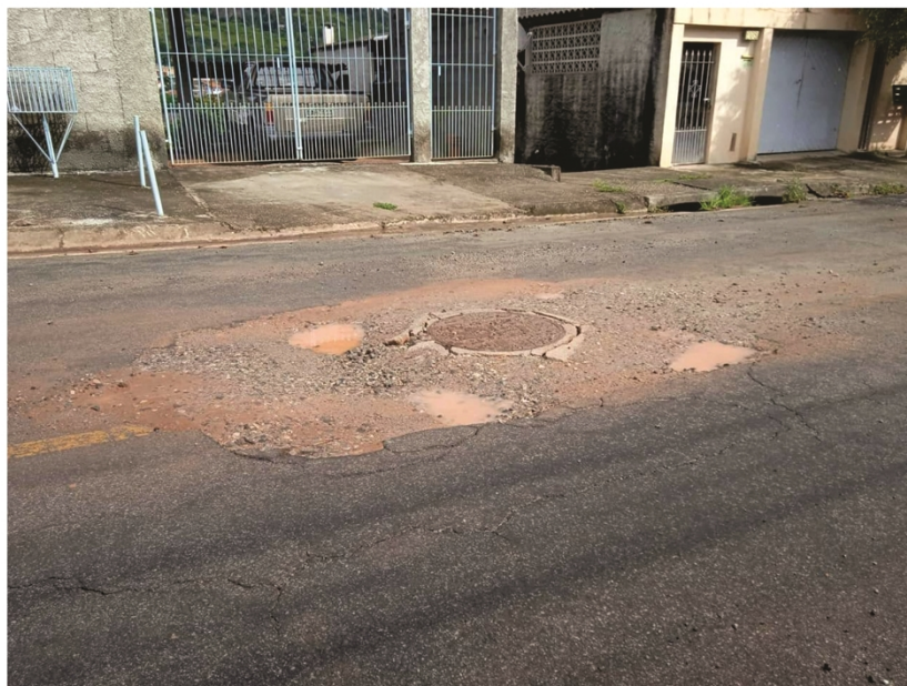
Rua Manoel Lessa, nº 206, Vila Nova São Roque
