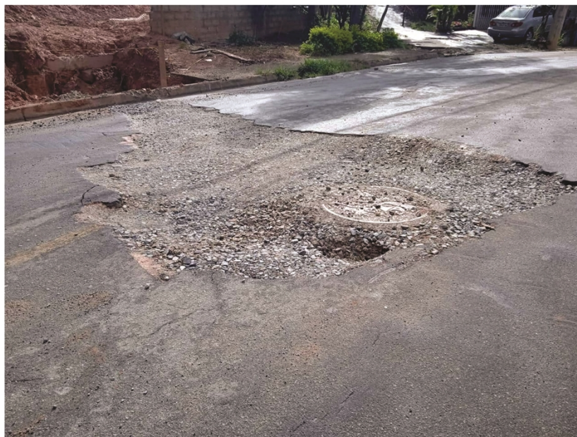
Rua Manoel Lessa, nº 170, Vila Nova São Roque
