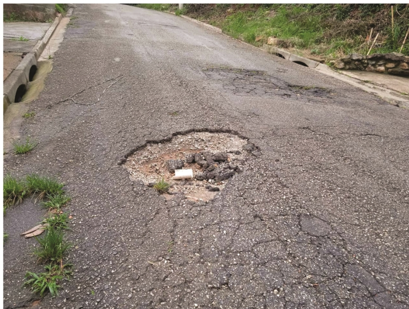
Rua Riolândia, nº 75, Vila Nova São Roque
