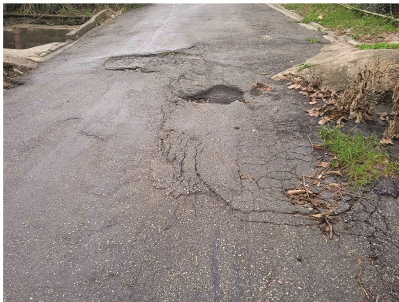
Rua Riolândia, nº 57, Vila Nova São Roque
