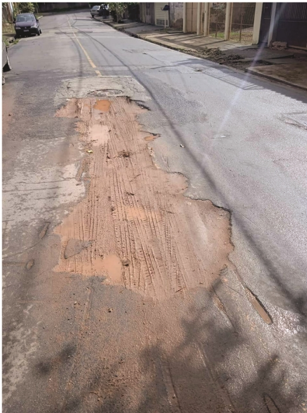
Rua Manoel Lessa, nº 82, Vila Nova São Roque
