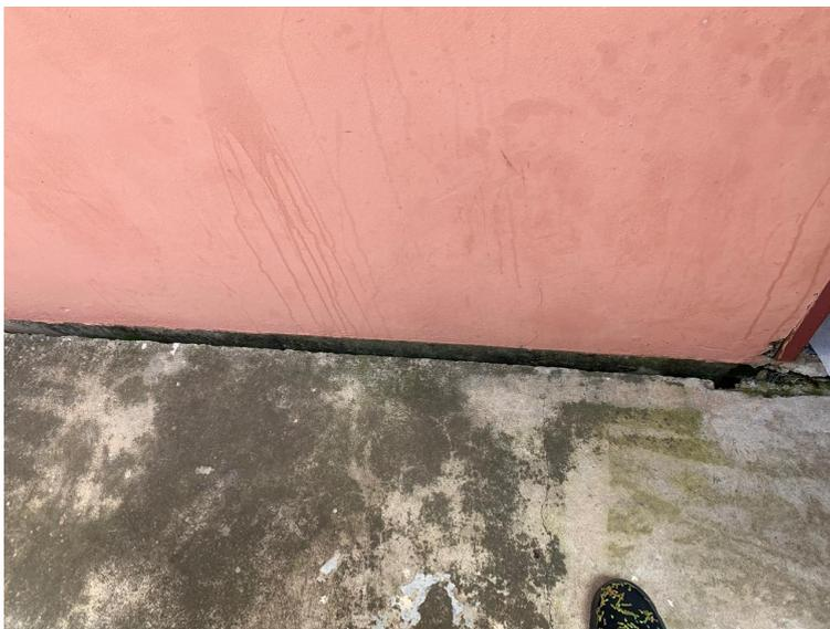
Obs.: Calçada existente na parte dos fundos da EMEI do Paisagem Colonial ao lado do muro que contém trincas, com erosão (água da chuva infiltrando no local)
