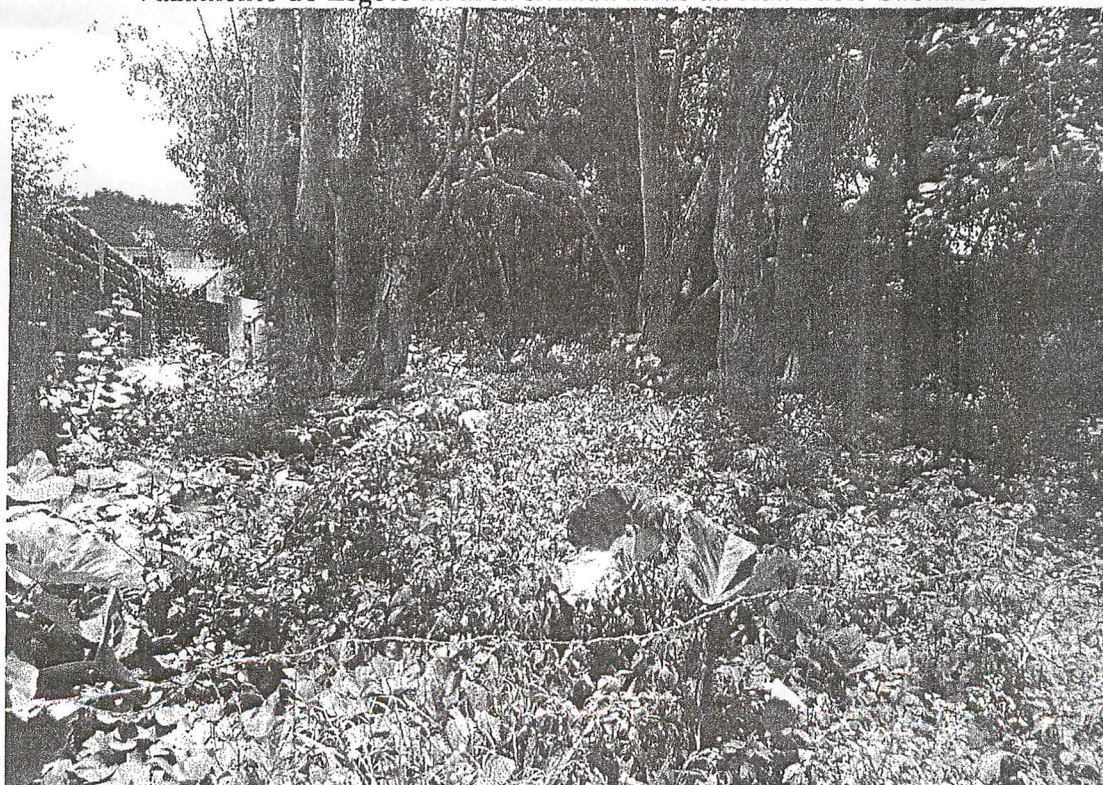
Mato cobrindo vazamento do esgoto (09.02.2021)
