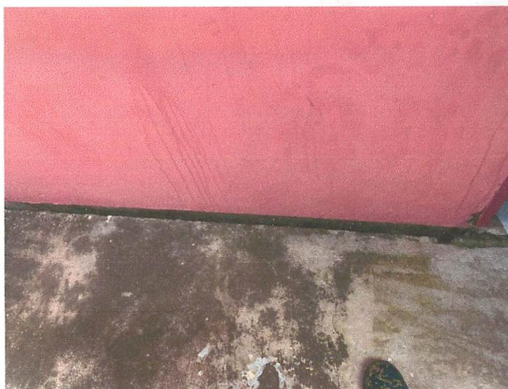
Obs.: Calçada existente na parte dos fundos da EMEI do Paisagem Colonial ao lado do muro que contem trincas, com erosão (água da chuva infiltrando no local)
