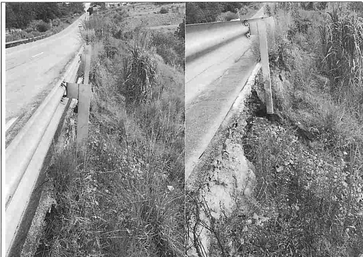
Foto n.º 20 – Km 7,5 – agravamento da erosão do talude
