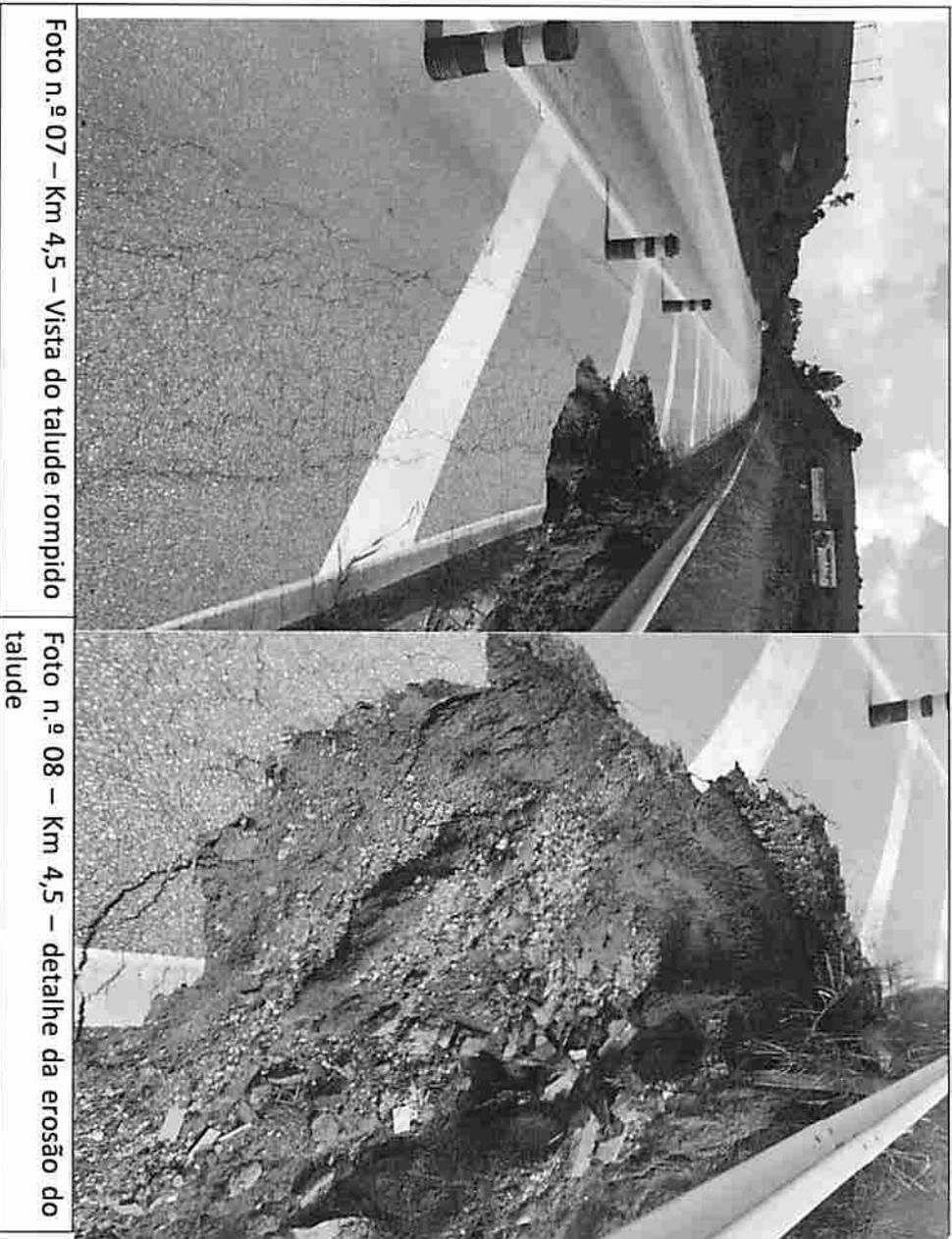
Foto n.º 07 – Km 4,5 – Vista do talude rompido
