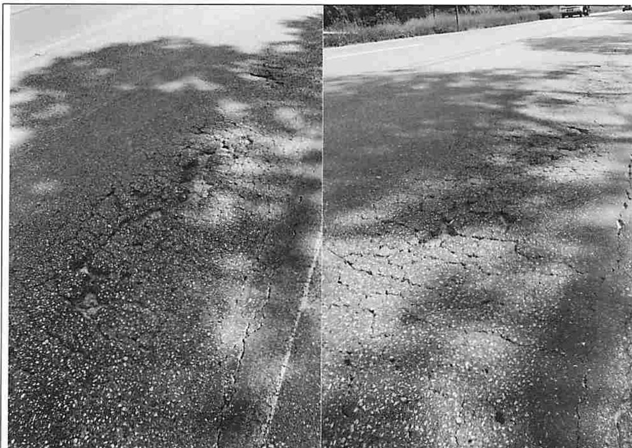
Foto n.º 01 – Km 02 – Trincas, fissuras e buracos na pista de rolamento da Rodovia
