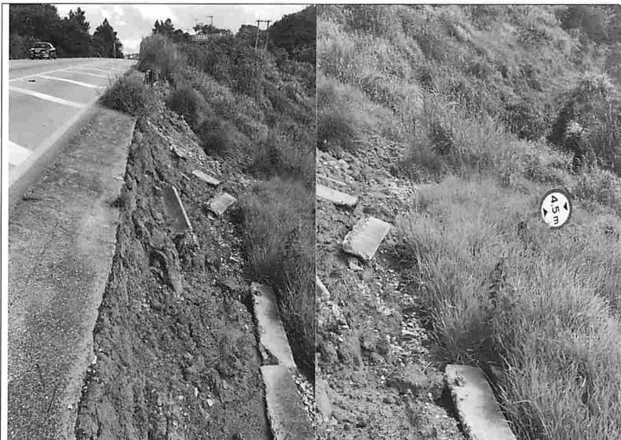
Foto n.º 24 – Km 08 – erosão do talude e rompimento da canaleta de concreto
