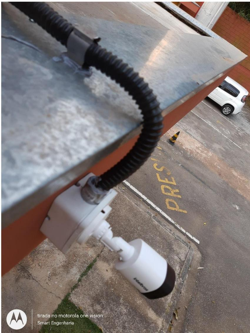
**CÂMERA EXTERNA COM CAIXA DE PROTEÇÃO E TUBULAÇÃO PARA PROTEÇÃO DO CABO 4MM**
