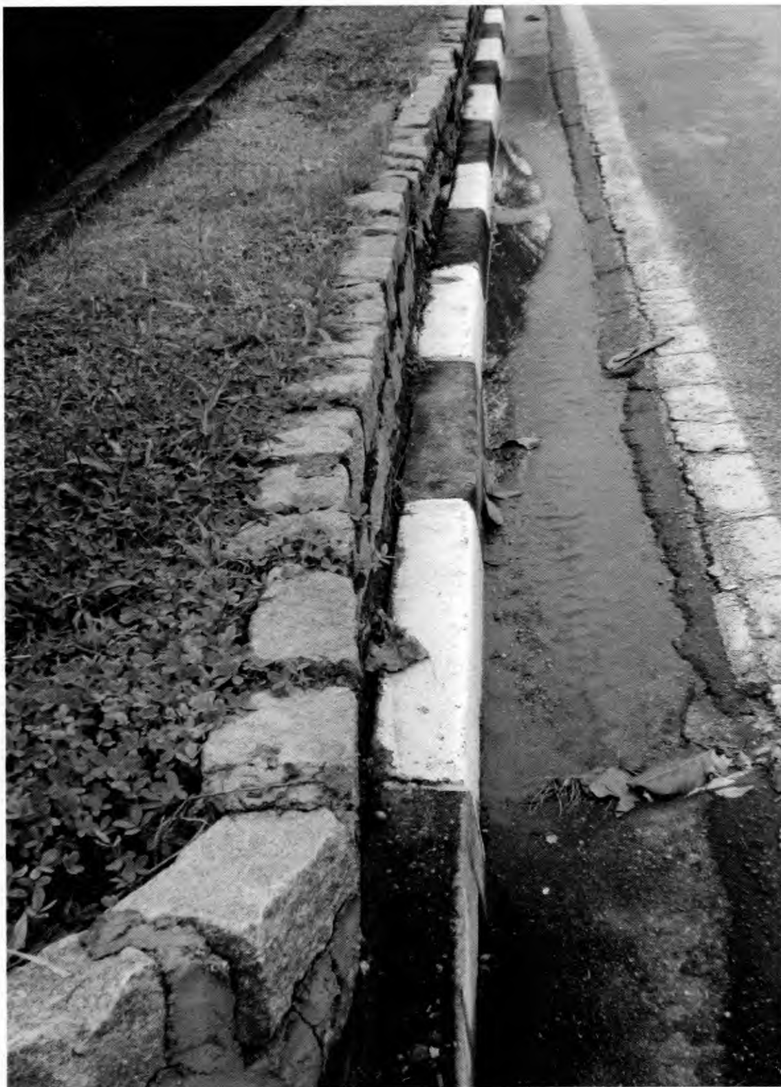
Afundamento da canaleta de escoamento da água, com desnível para dentro do rio.
