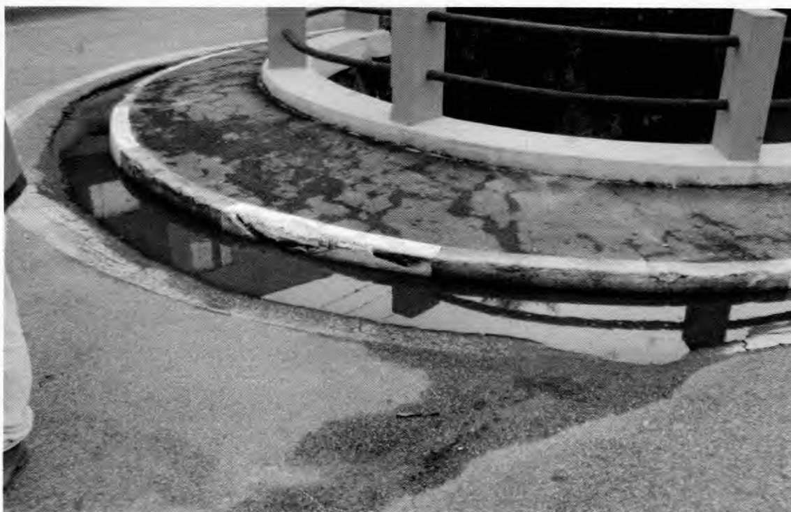
Afundamento do piso no retorno da avenida, com interdição do local ao trânsito de veículos.
