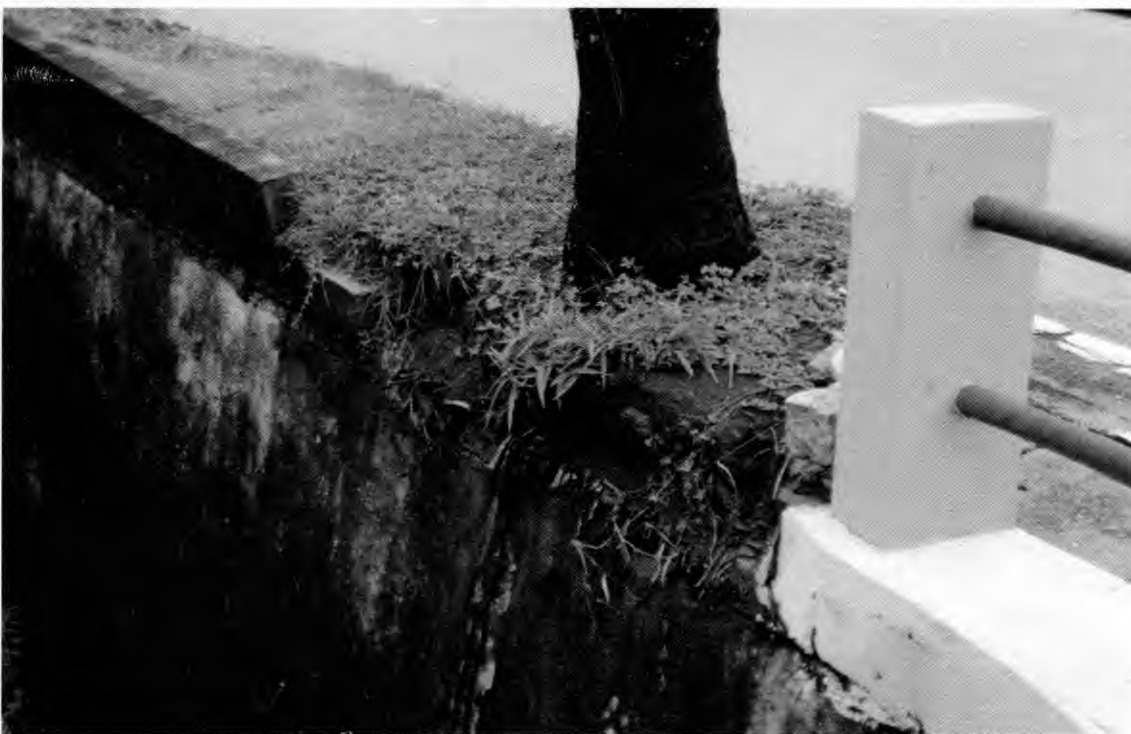
Palmeira imperial contribuindo com seu peso para a destruição da estrutura do paredão.
