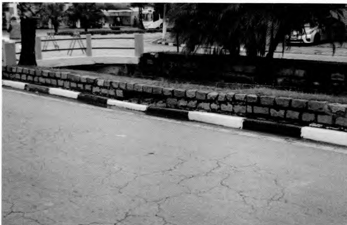
Afundamento da mureta de sustentação da margem do rio, atingindo o leito da via.
