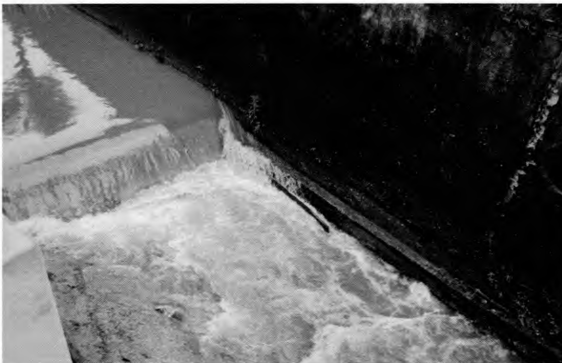
Margem esquerda do rio com infiltração debaixo do paredão.
