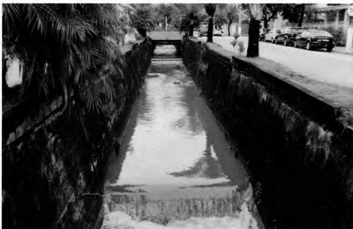
Palmeiras imperiais que plantadas em local inadequado, contribuem para desestabilização do paredão das margens do rio, devido ao seu peso e dimensões.
