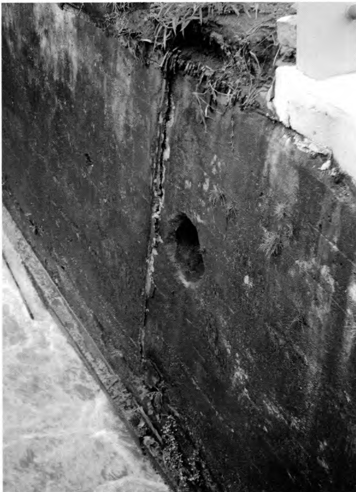
Rachadura no paredão da margem esquerda do rio.
