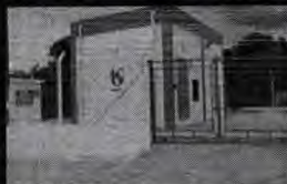
PIRACAJÁ - SP Estações Elevatórias de Esgoto - DRR
