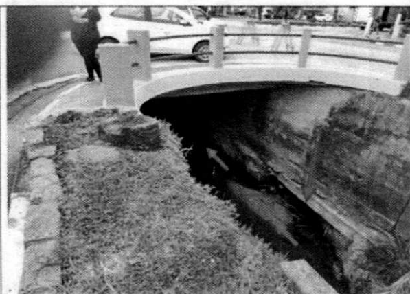
FOTO 5 – Solapamento na margem direita (seta vermelha) e depósito de sedimento (seta marrom) e a seta azul sentido do escoamento das águas.
