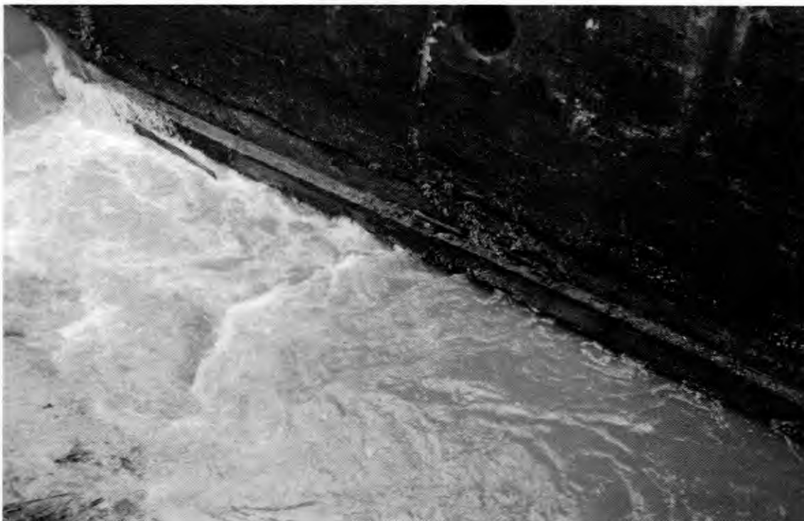
Infiltração da correnteza do rio embaixo do paredão de sustentação.
