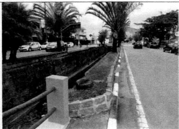
FOTO 6 – Vista geral onde ocorrem as movimentações, a seta amarela indica um ponto de movimentação.
