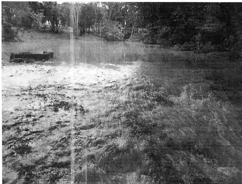
Foto 22. Local próximo do lago 2 onde a água está passando por cima do talude, houve erosão e com a força da água a vegetação foi retirada.
