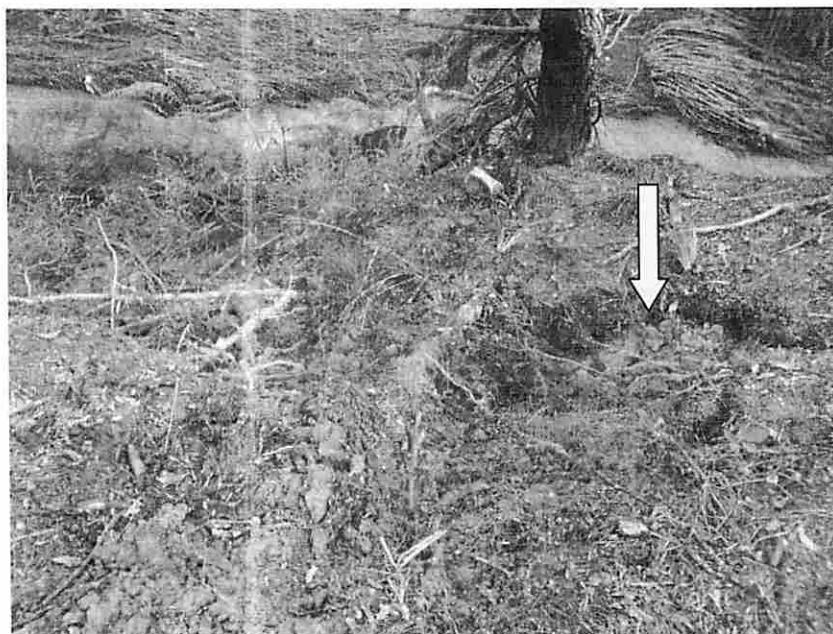
Foto 57. Formação da erosão próximo ao córrego.
