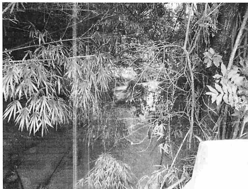
Foto 44. Vegetação arrancada pela força da água dentro do córrego, sugerimos a retirada e a limpeza.
