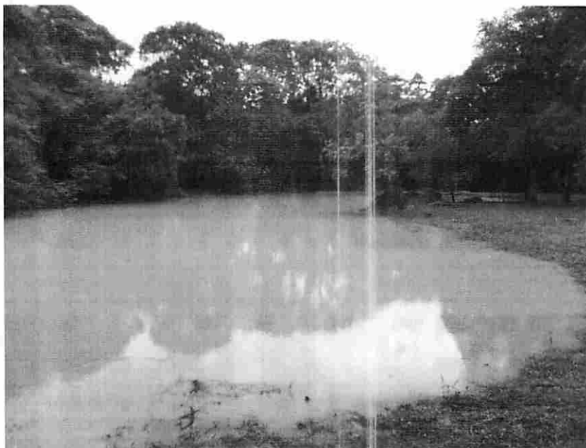
Foto 20. Lago ao lado do Xv de novembro recebendo água do outro lago ao lado, já completo e foi constatado início de rompimento.
