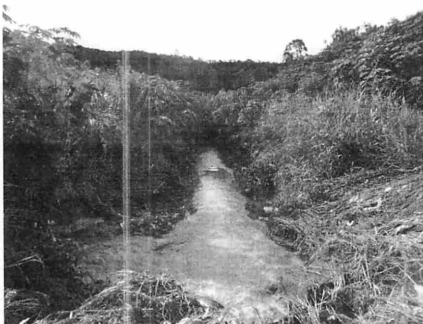
Foto 33. Córrego no goiana, nota-se que necessita de uma limpeza.
