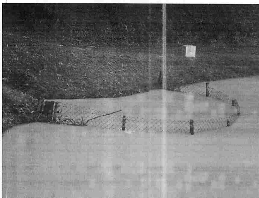
Foto 13. Proteção do sangradouro.
