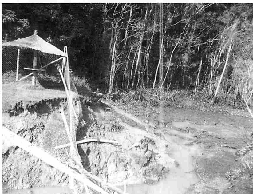
Foto 08. Local onde recebia a água de um córrego ali existente, rompido provavelmente por ter entupido a boca e com o aumento do volume de água.
