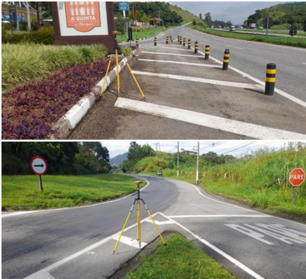
Figura 47 Implantação dos Pontos de Apoio
