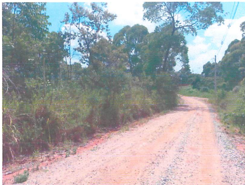
Foto 04 - VISTA DO LOGRADOURO 02
