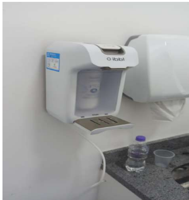
Instalação de filtro na copa
