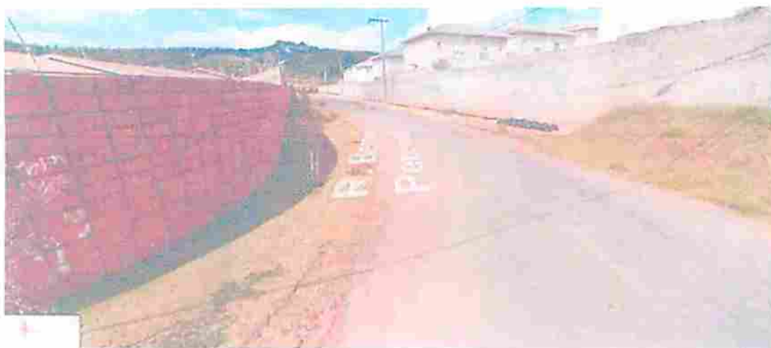
Via no município de São Roque.
