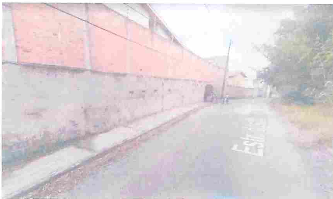
Via no município de São Roque.
