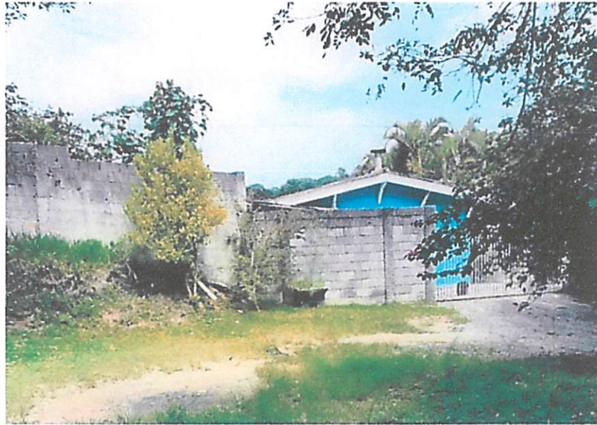
Foto 06 - Vista interna lado esquerdo
