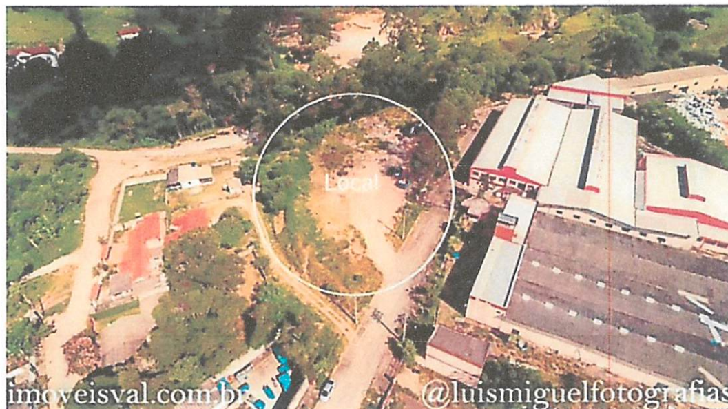
Foto 01 - Foto área do local do imóvel avaliando
