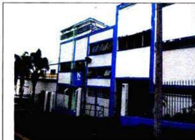
Foto 73: ETA São Roque
