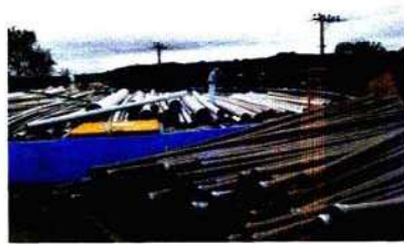
Foto 76: ETA São Roque - Materiais armazenados de forma inapropriada
