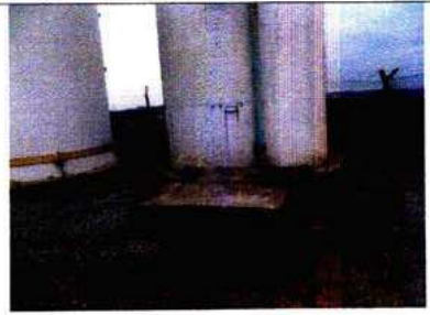
Foto 42: Reservatório Planalto Vista Verde – Caixa de Manobra em manutenção.
