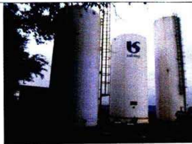
Foto 41: Reservatório Planalto Vista Verde
