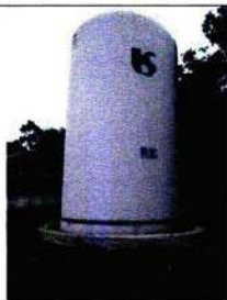
Foto 63: Reservatório Jd. Marieta
