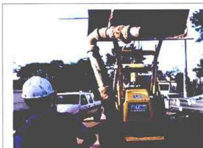
Foto 1 – Remanejamento Integral do trecho avariado.
