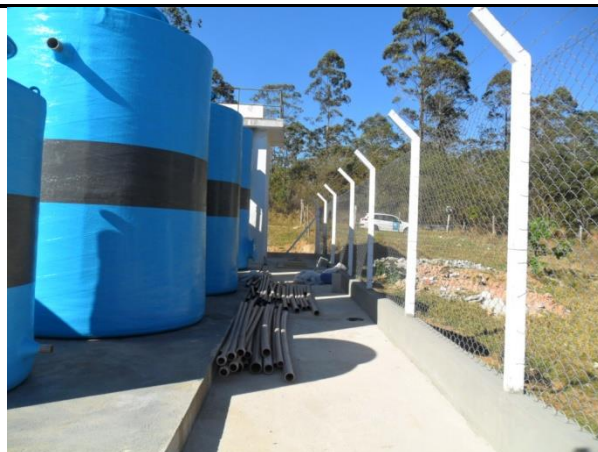
Foto 2 – Execução de obras.
