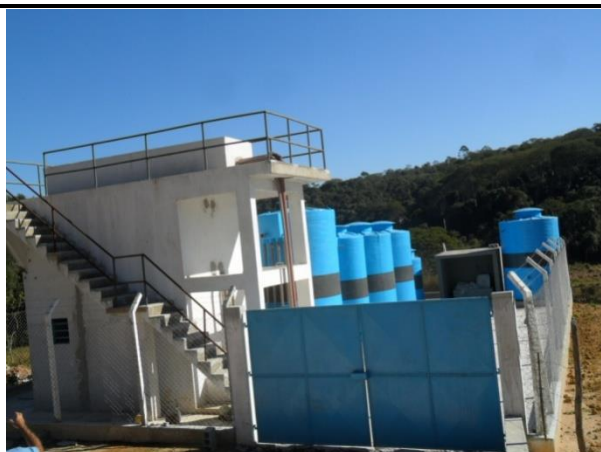
Foto 1 – Vista geral da ETE em primeiro plano.
