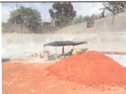
Foto 5 – Vista geral da EEE-final em execução.
