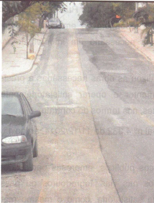
Foto 7 – Vista geral da Av. Três de Maio. Neste local foi executados serviços de implantação de rede coletora de esgoto pela SABESP.
