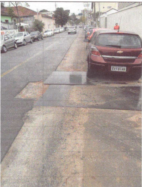
Foto 9 – Detalhe da execução da obra.
