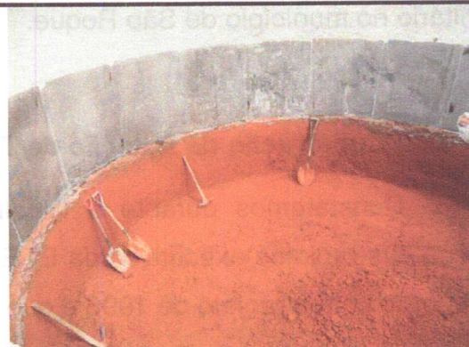
Foto 6 – Escavação dos poços de sucção.
