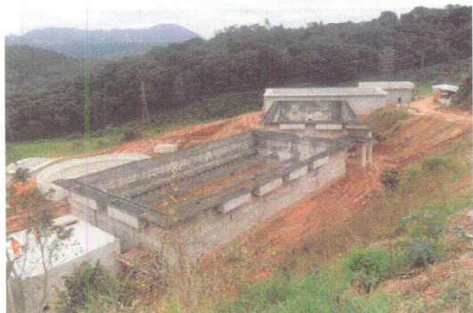
Foto 1 – Vista geral da ETE em primeiro plano UASB e tanques de Aeração.
