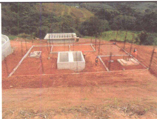
Foto 2 – Execução de obras.
