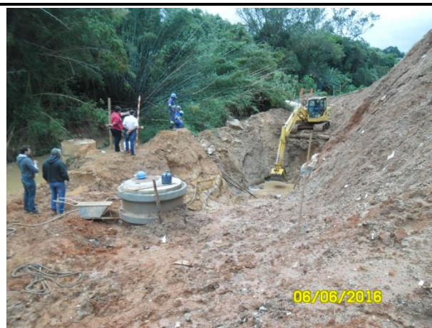
Foto 10 – Obras de reconstrução.
