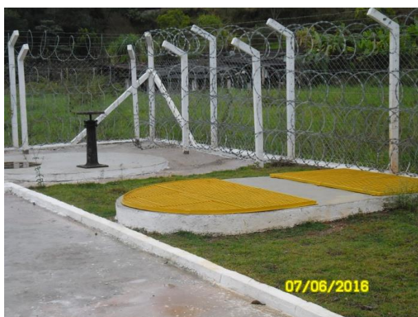
Foto 18 – Os equipamentos foram instalados.
