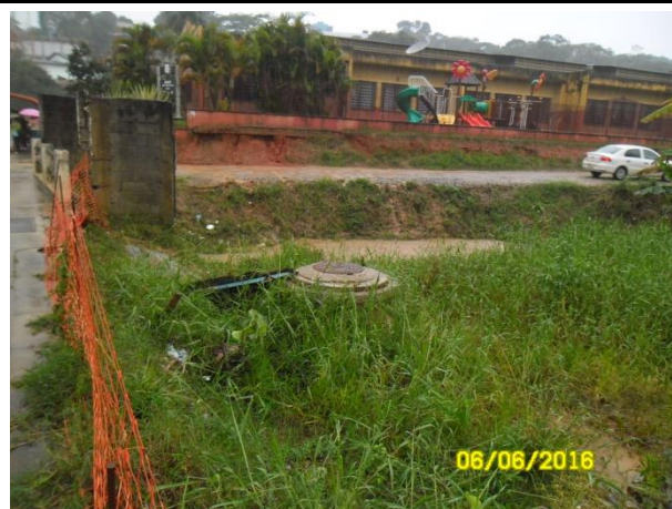
Foto 14 – Executadas 25 % da obras civis.
