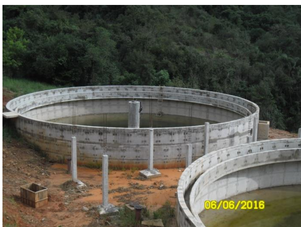
Foto 5 – Execução das obras: decantadores.
