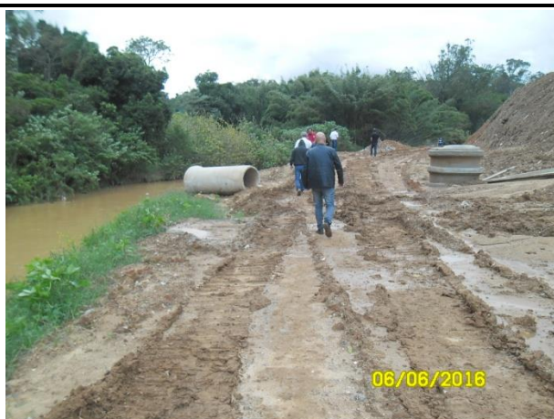
Foto 9 – Caminhamento do coletor tronco.
