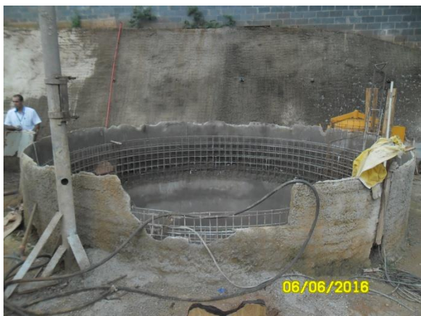
Foto 7 – Vista geral da EEE Final em execução (poço de sucção).
