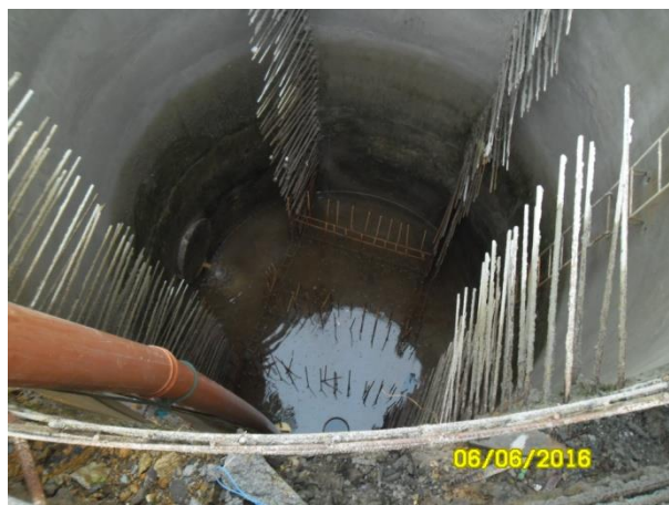
Foto 8 – Poço de gradeamento.
