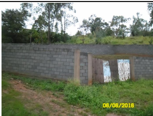
Foto 11 – Vista externa da instalação.
