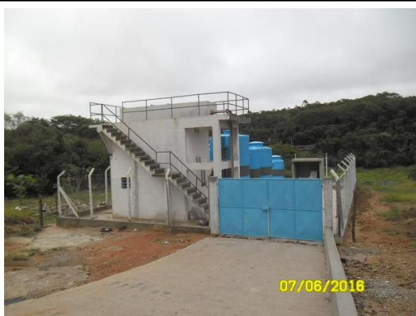
Foto 20 – Vista geral externa.
