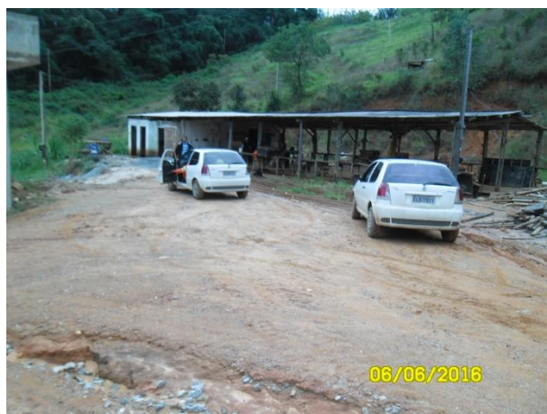
Foto 4 – Canteiro de obra.
