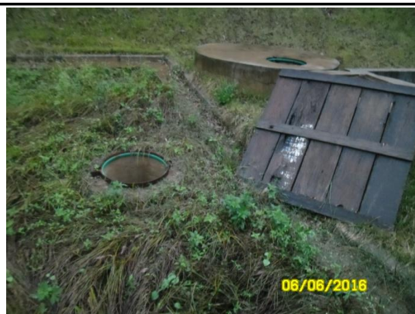
Foto 12 – Executadas 75 % da obras civis.
