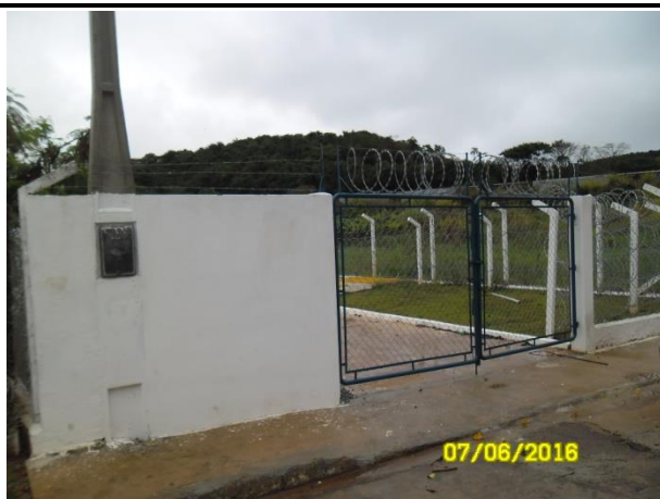
Foto 16 – Vista geral externa.
