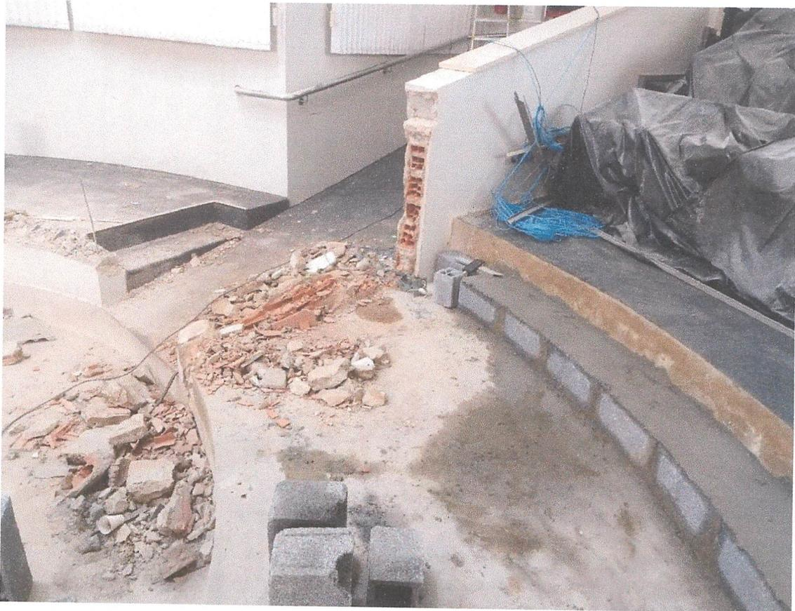
*Foto 8 – Demolições e ampliação do patamar do plenário.*
