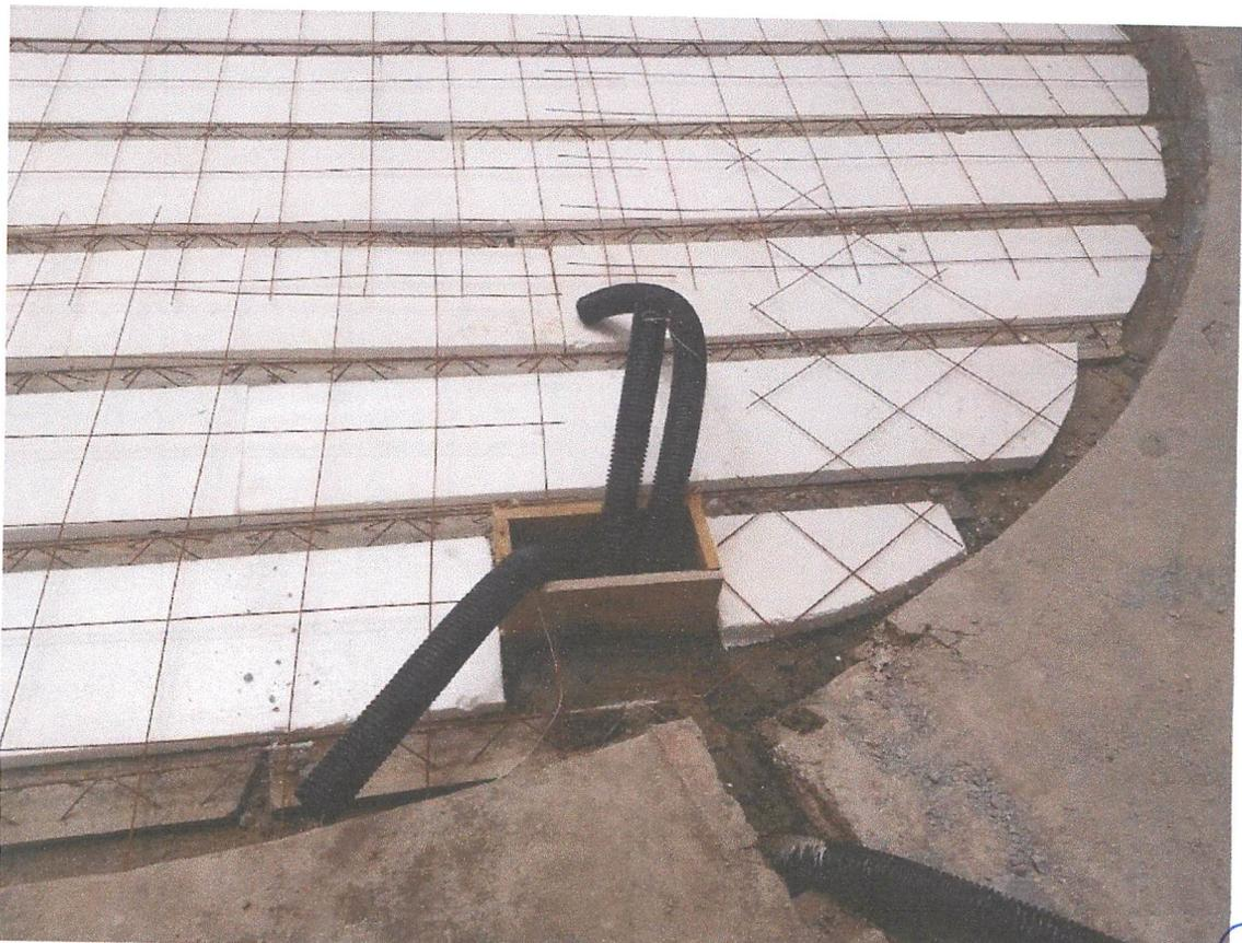
*Foto 11 – Montagem da infraestrutura das instalações de áudio, energia e lógica.*
