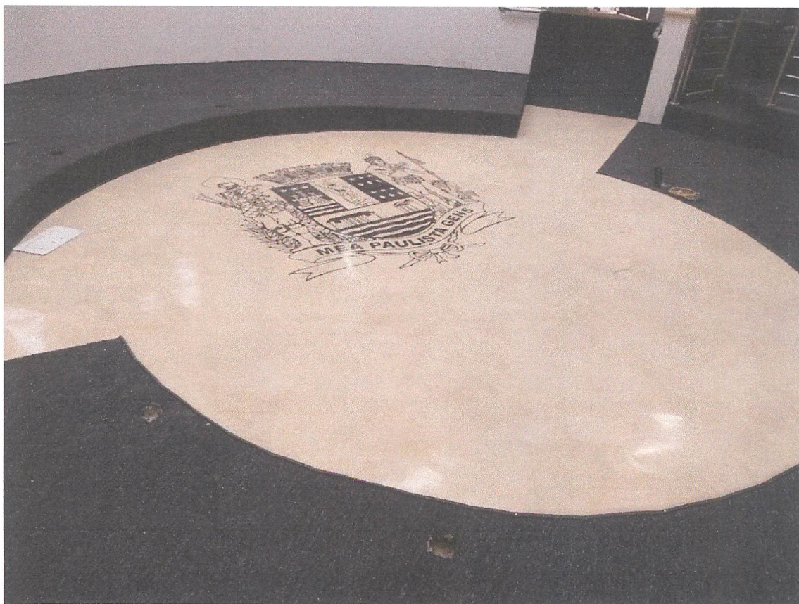
Foto 25 – Detalhe do piso e carpete instalados.
