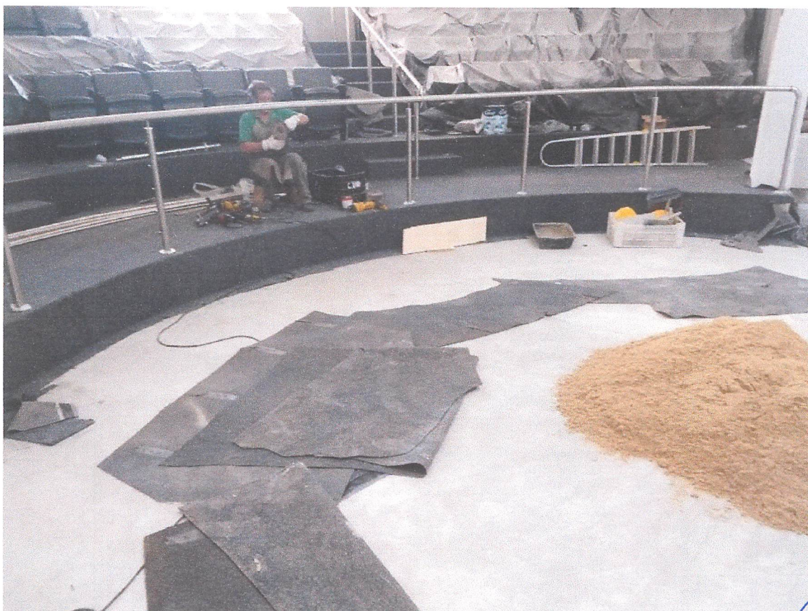
Foto 17 – Execução do gradil de proteção em aço inox.
