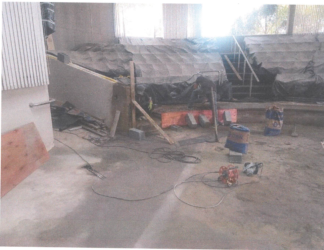
Foto 14 – Detalhe do piso concretado e da ampliação da arquibancada do plenário.
