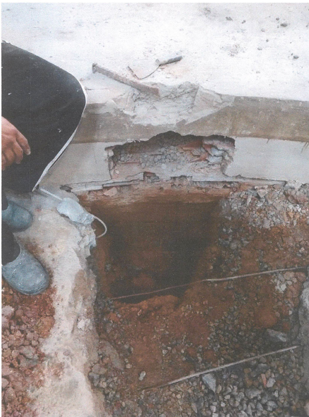
Foto 7 – Detalhe da sondagem da estrutura, para melhor avaliação técnica
