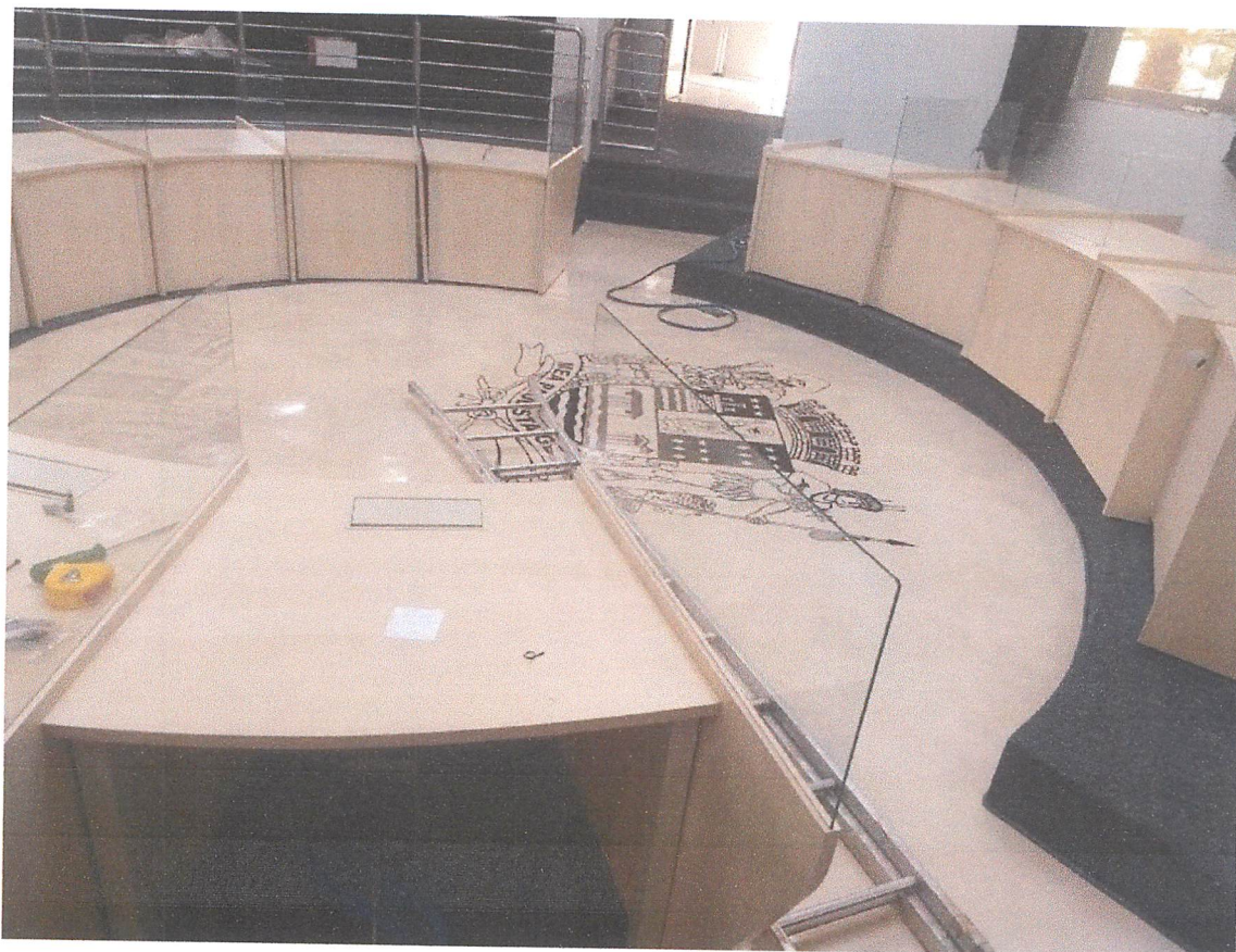
Foto 26 – Detalhe da montagem dos móveis.
