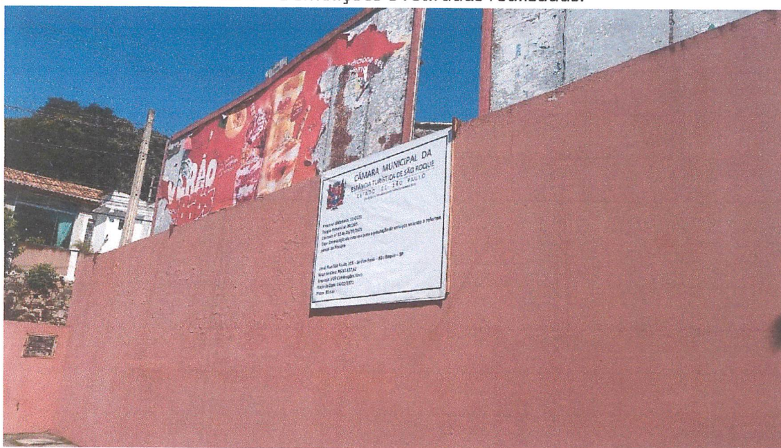
Foto 4 – Placa da Obra
