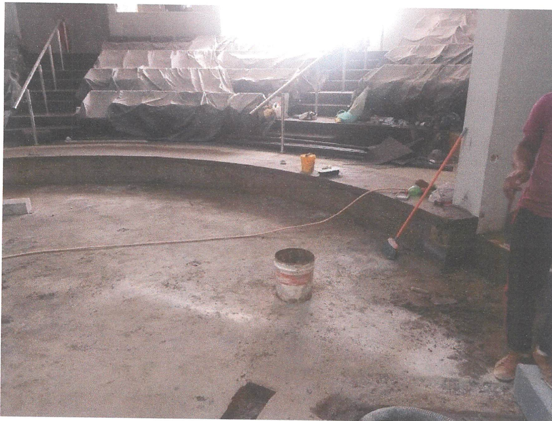
Foto 15 – Detalhe do piso concretado e da ampliação da arquibancada do plenário.
