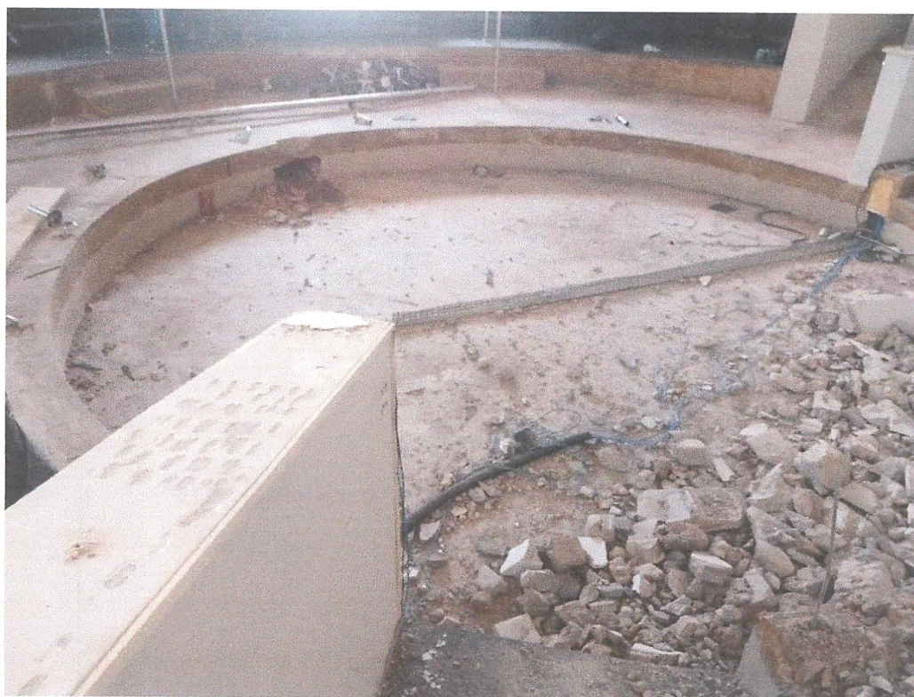
Foto 6 – Demolições e Retiradas Realizadas.
