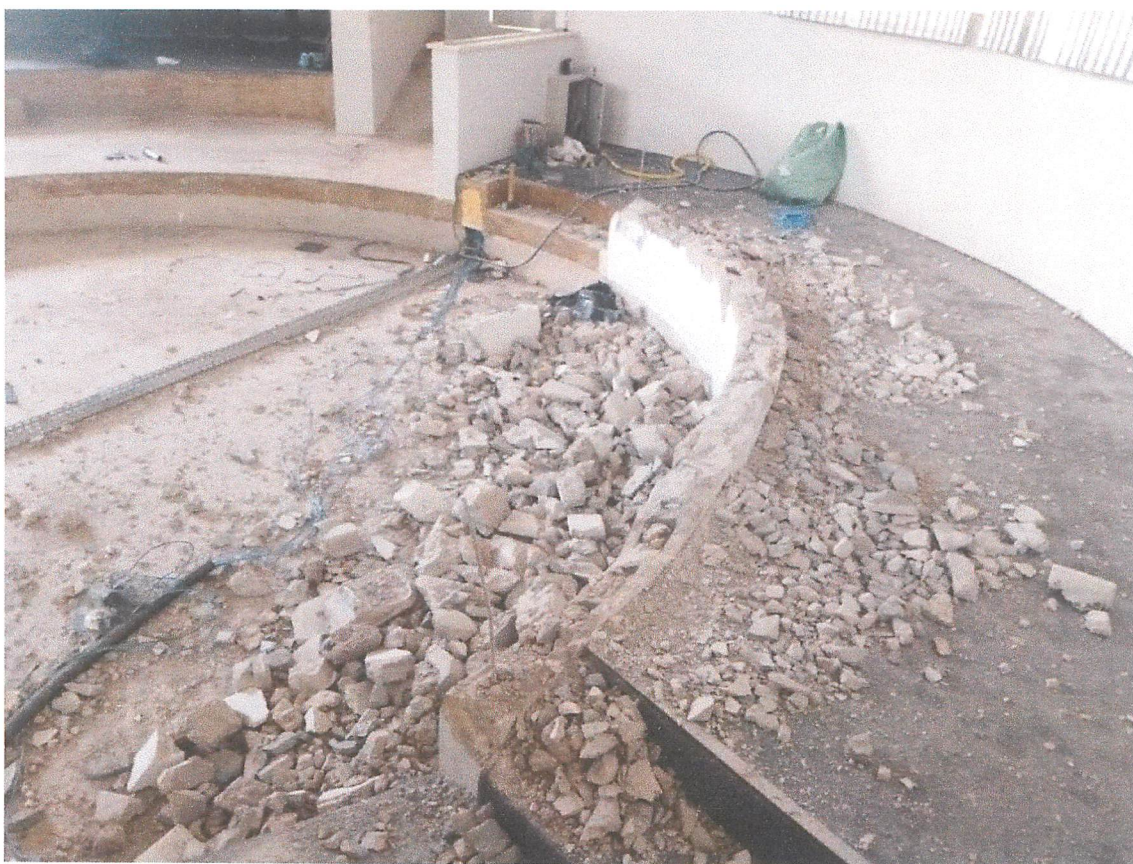
Foto 5 – Demolições e Retiradas Realizadas.
