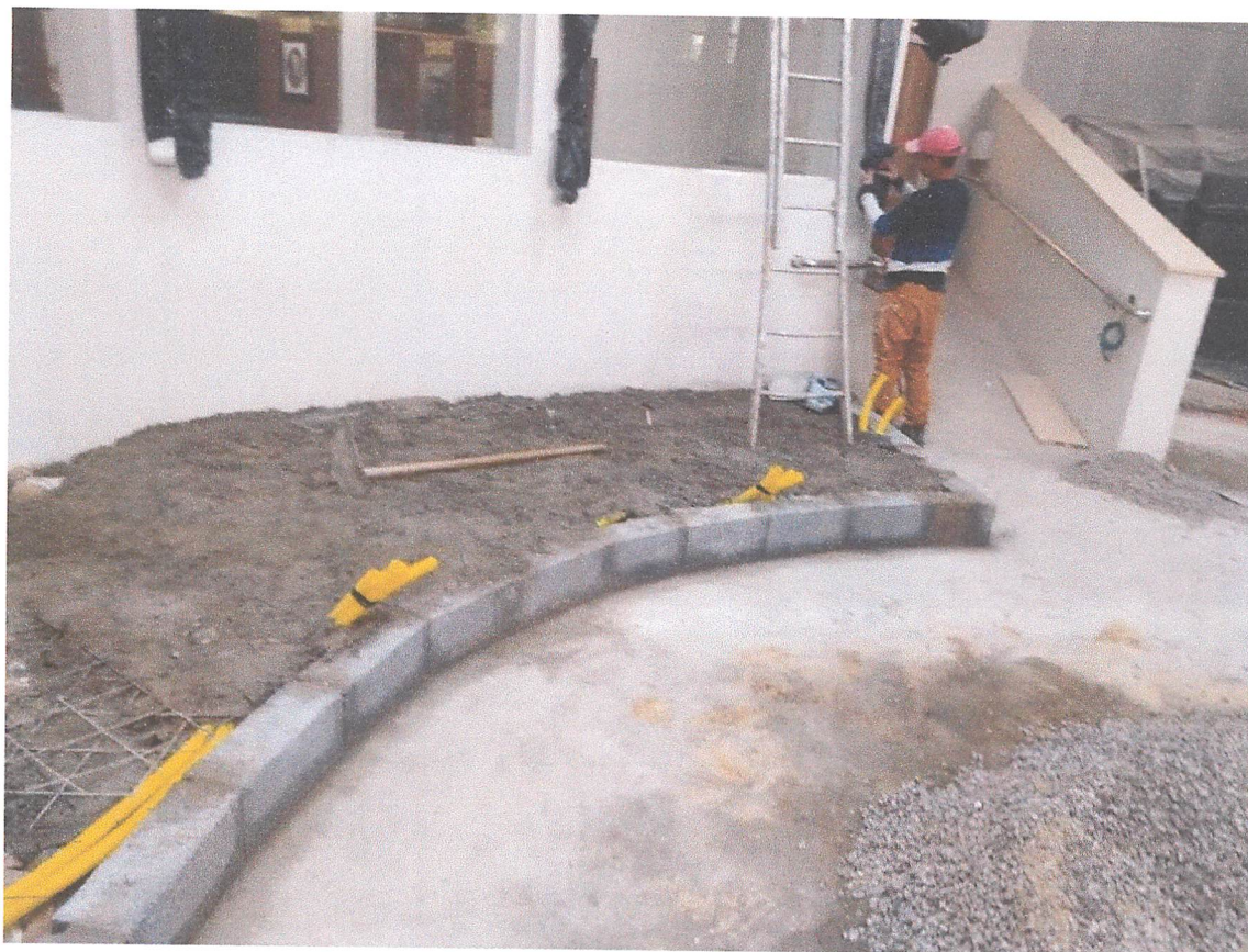
Foto 19 – Concretagem e execução de infraestrutura de áudio, energia e lógica.
