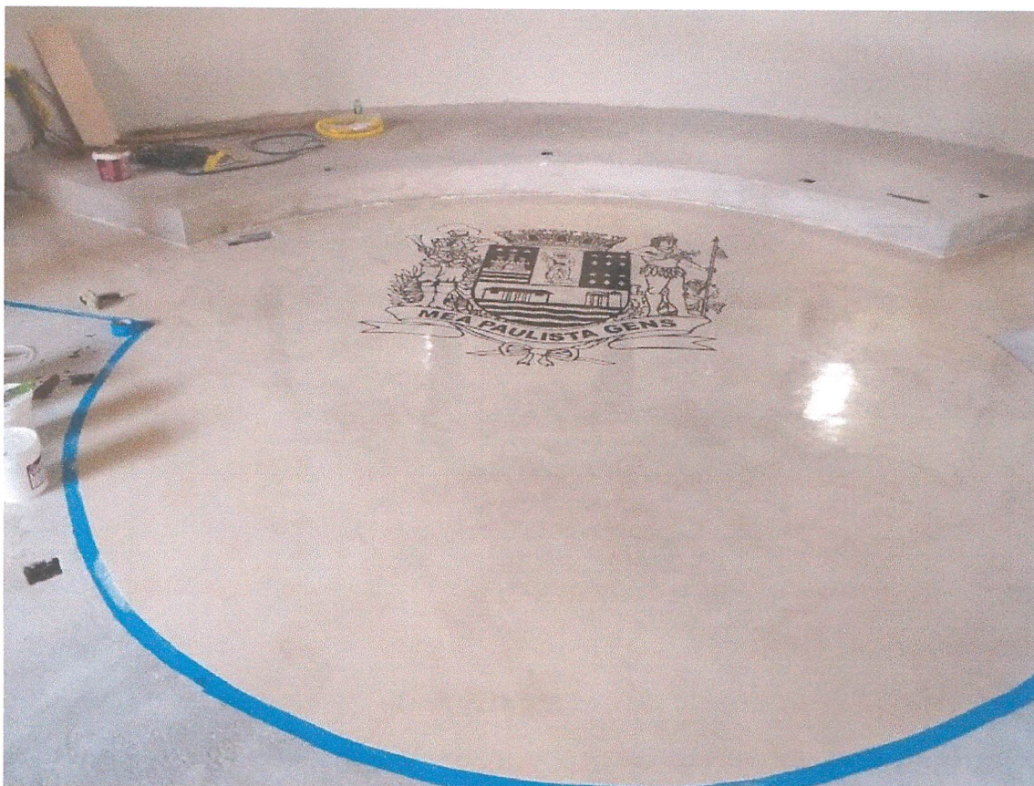
Foto 24 – Execução do piso, com o detalhe do adesivo com o brasão da cidade.
