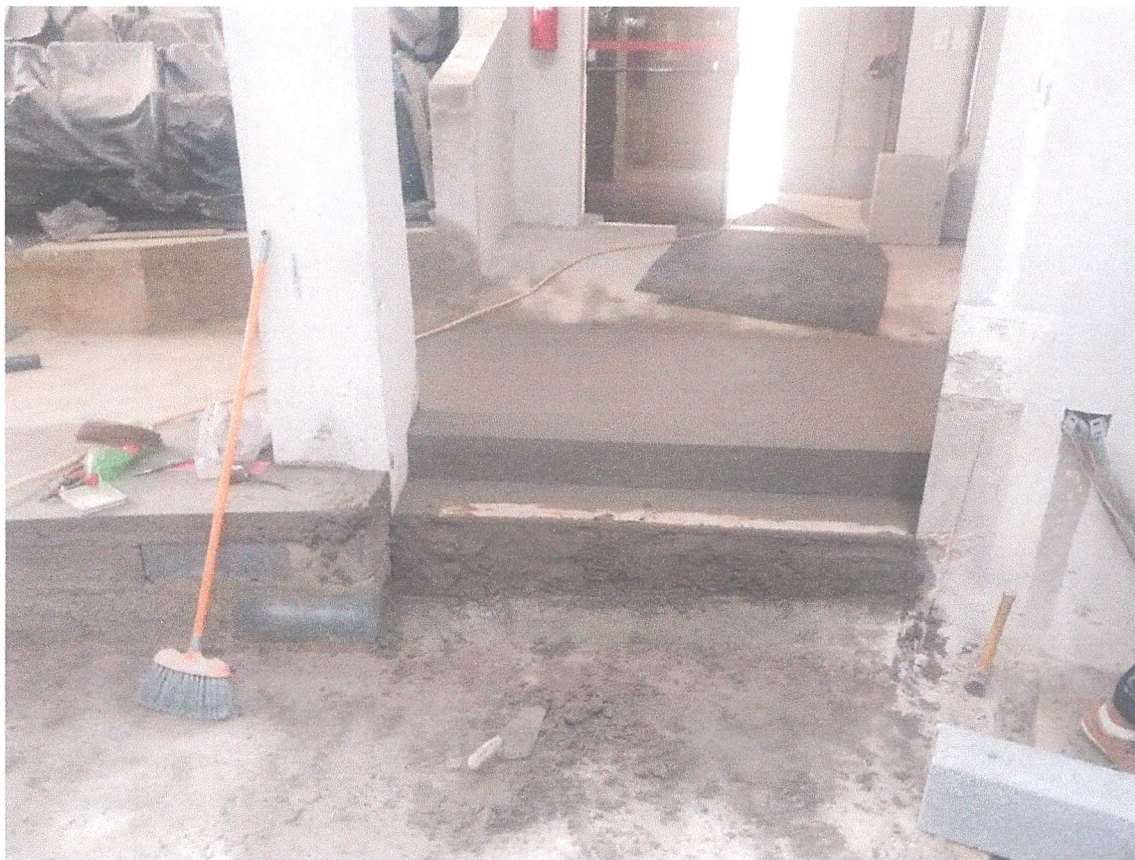
Foto 16 – Detalhe do acerto da rampa de acesso e novos degraus.
