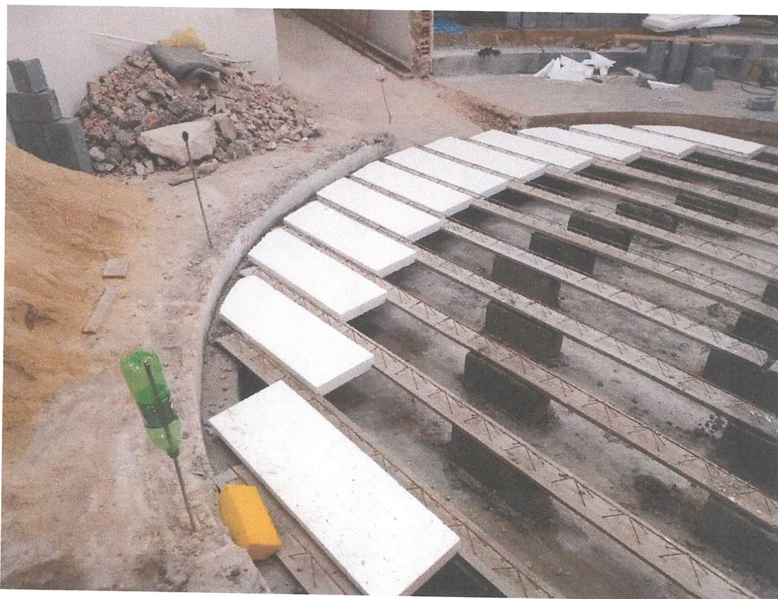
Foto 10 – Montagem da estrutura do plenário.
