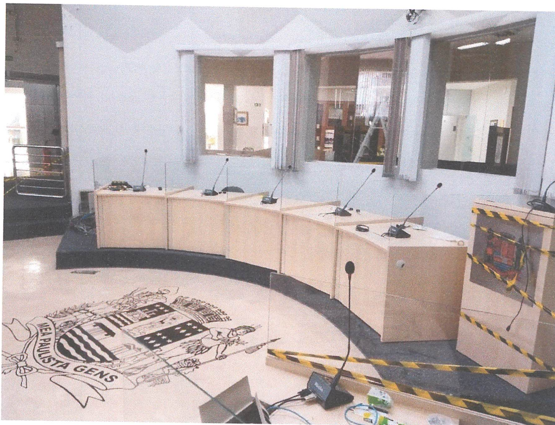
Foto 27 – Montagem final das instalações.
