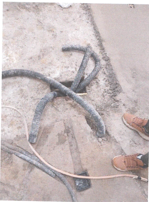
Foto 12 – Montagem da infraestrutura de áudio, energia e lógica.
