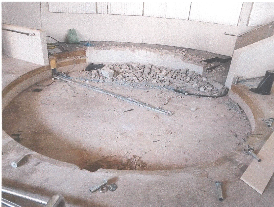
Foto 3 – Demolições e retiradas realizadas.
