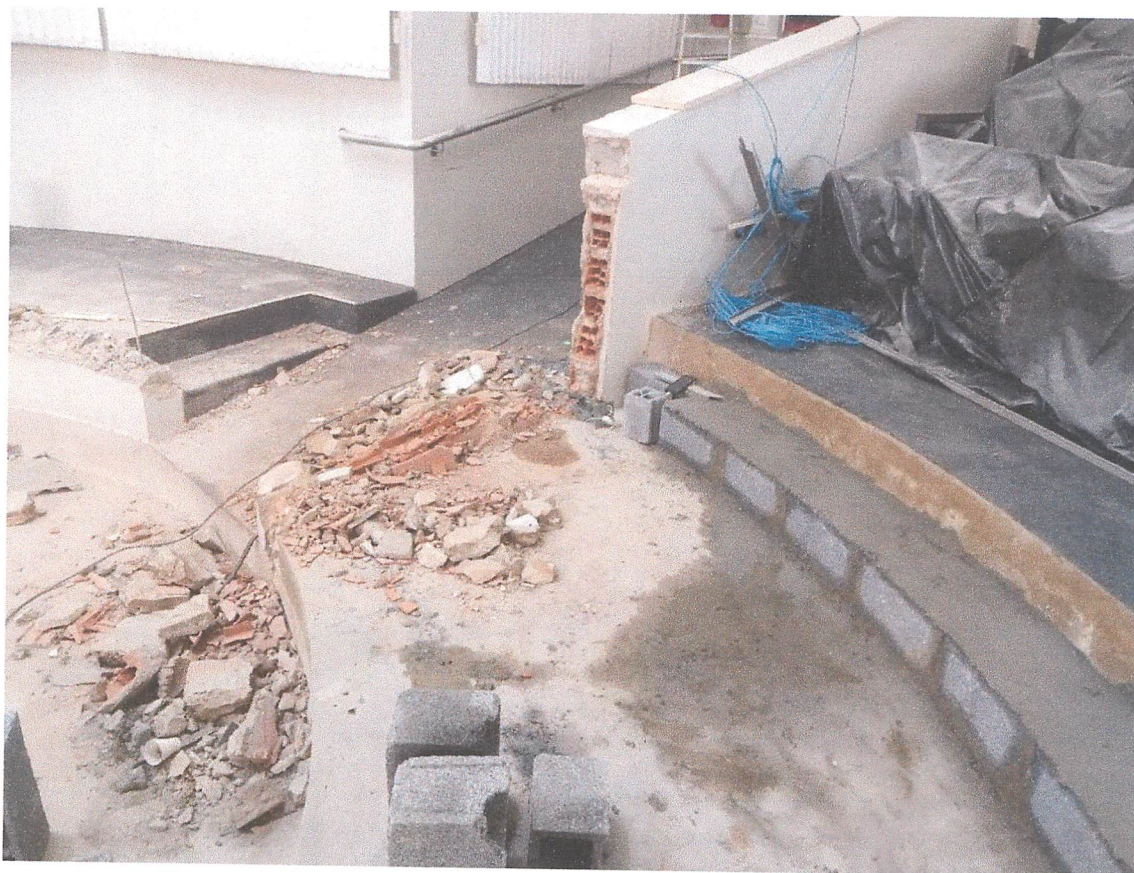
Foto 8 – Demolições e ampliação do patamar do plenário.
