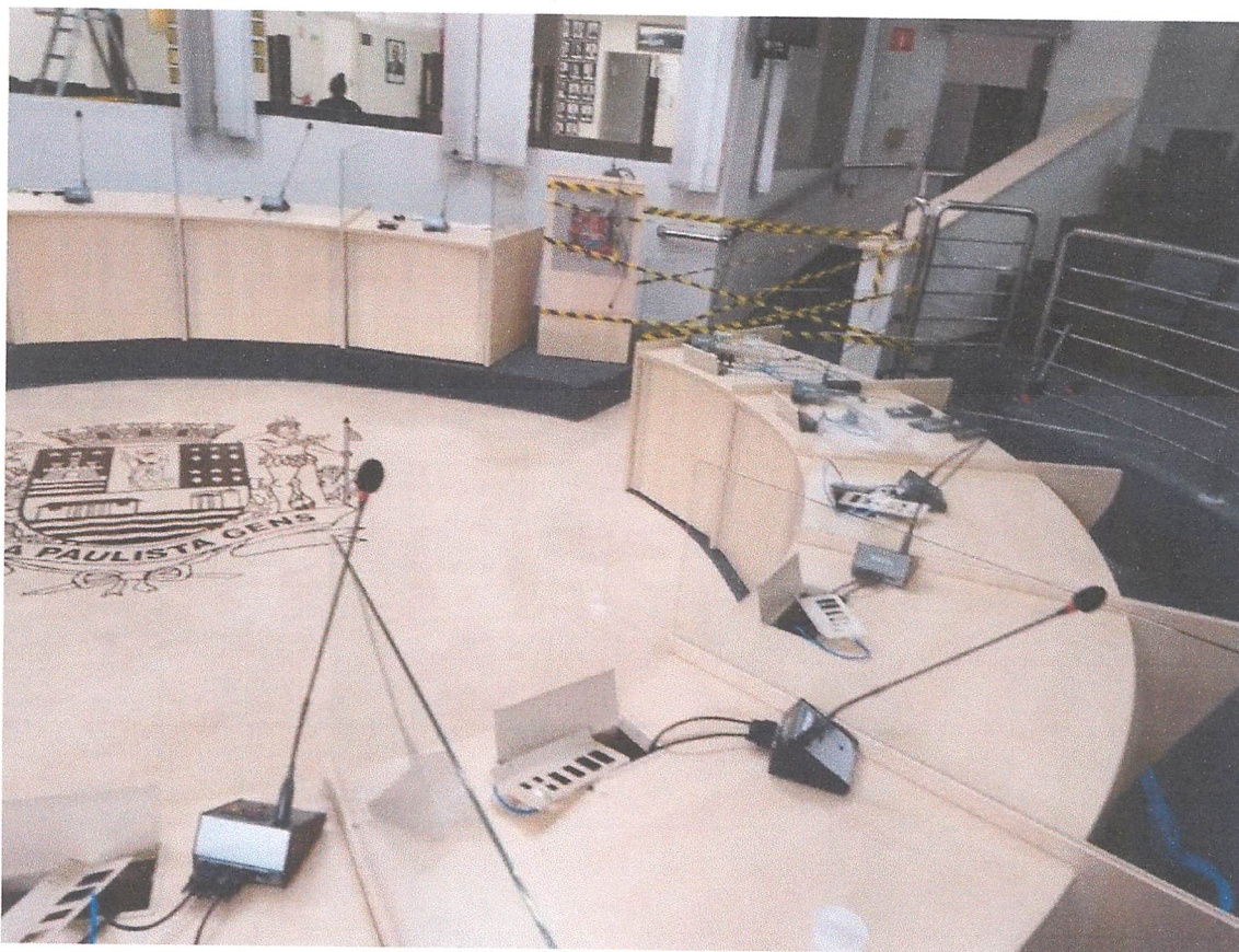
Foto 28 – Montagem final das instalações.
