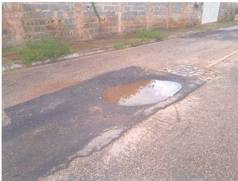
Rua Auriflama, nº 69, Vila Nova São Roque
