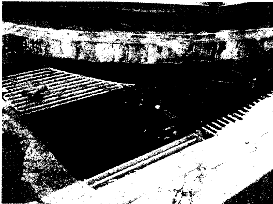
Figura 49 - Bueiro com grelha metálica na Av. Tiradentes
