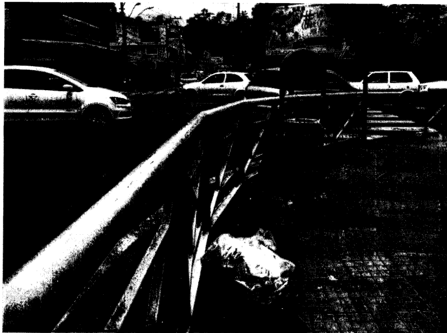
Figura 40 Lixeira e Guarda Corpo na Av. Tiradentes. Centro.
