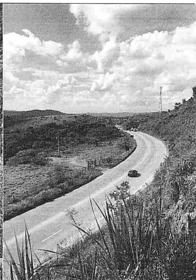
Foto n.º 16 – Km 05 – Vista da área invadida
