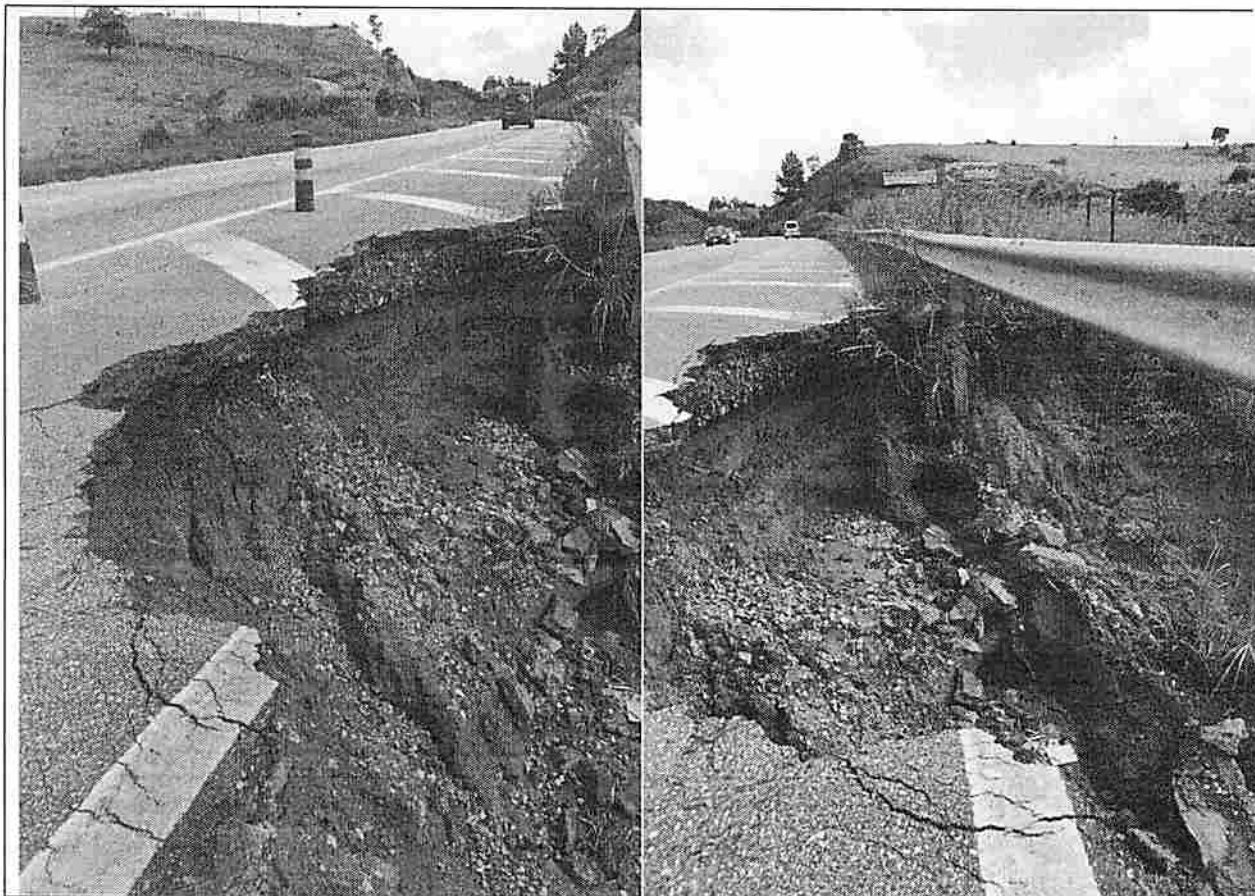
Foto n.º 09 – Km 4,5
