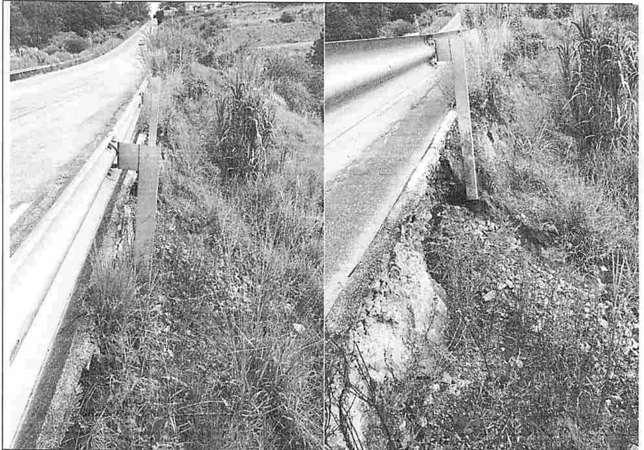
Foto n.º 20 – Km 7,5 – defensas metálicas sem função estrutural
