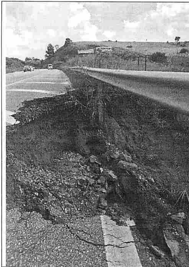
Foto n.º 11 – Km 4,5
