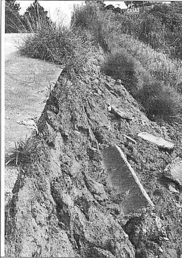
Foto n.º 25 – Km 08
