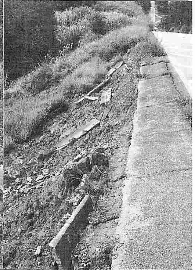
Foto n.º 26 – Km 08
