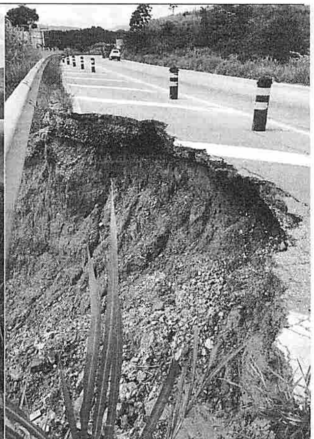
Foto n.º 12 – Km 4,5
