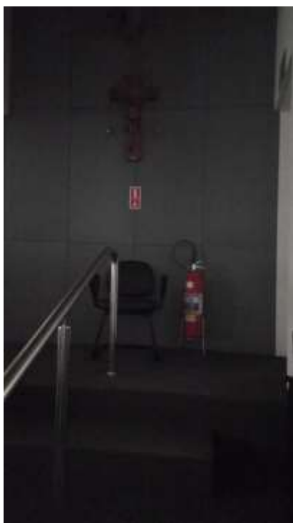
FIGURA 3. Extintores instalados de forma incorreta.
