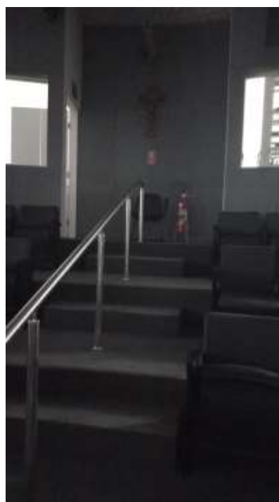
FIGURA 3. Extintores instalados de forma incorreta.
