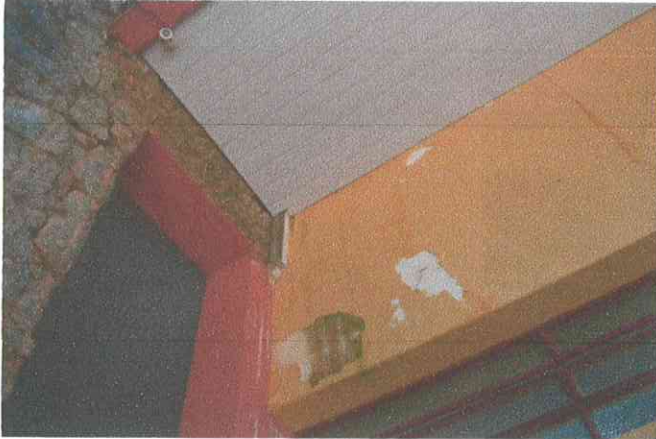
9-) Falta de pintura em todo o prédio e suspeita-se de problemas no telhado:
